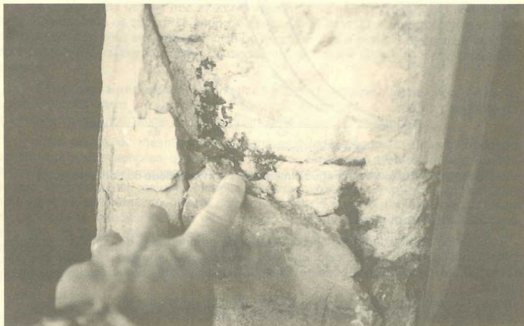
Figura 5.41 - Desagregação do concreto devido à expansão por corrosão da armadura. Concreto de elevada permeabilidade e pequeno recobrimento da armadura
