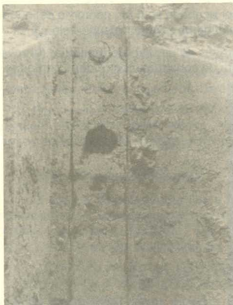
Figura 10.32 - Porções de concreto aderidos à forma, devido ao untamento deficiente
