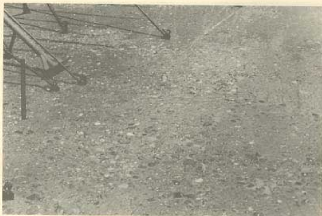
Figura 10.8 - Excesso do corte no concreto - Porto Primavera
