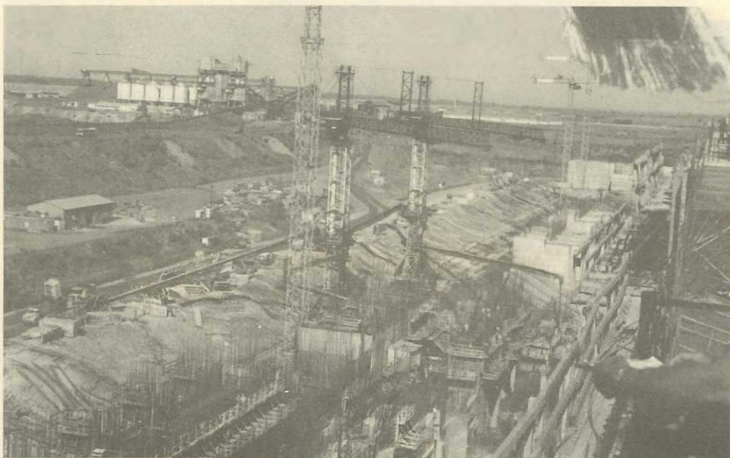
Figura 11.21 - Guindaste com lança em torre e com correia acoplada, para lançamento de concreto - Yacyreta/Argentina
