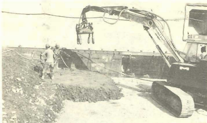
Figura 12.22 - Conjunto de vibradores de imersão acoplados à retroescavadeira - Itumbiara
