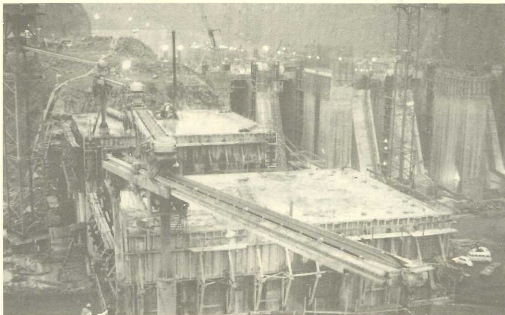
Figura 11.13 - Utilização de vários tramos de correia sobre rótula em apoio tubular - Itaipu
