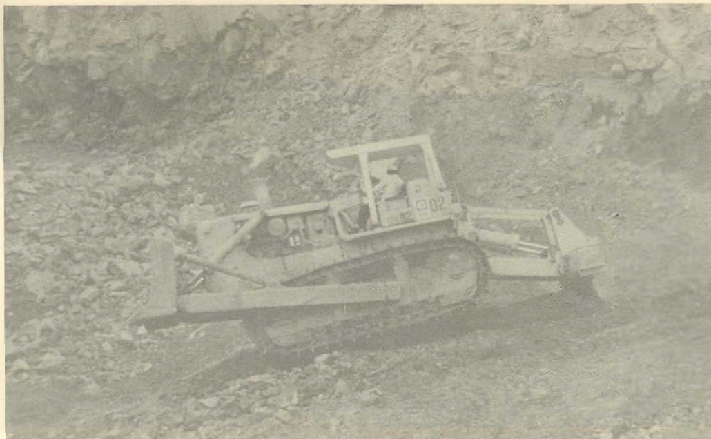
Figura 10.3 - Utilização de trator de lâmina frontal (Bulldozer) com dente (ripper) para o preparo da fundação - Itaipu
