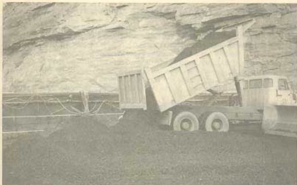
Figura 16.17 - Basculamento do CCR, na construção da Barragem de Capanda - Angola
