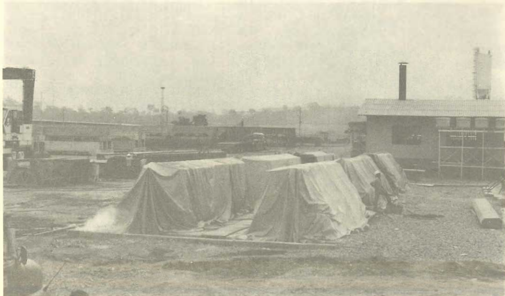
Figura 13.2 - A cura a vapor sendo aplicada em elementos pré-moldados -Tucuruí
