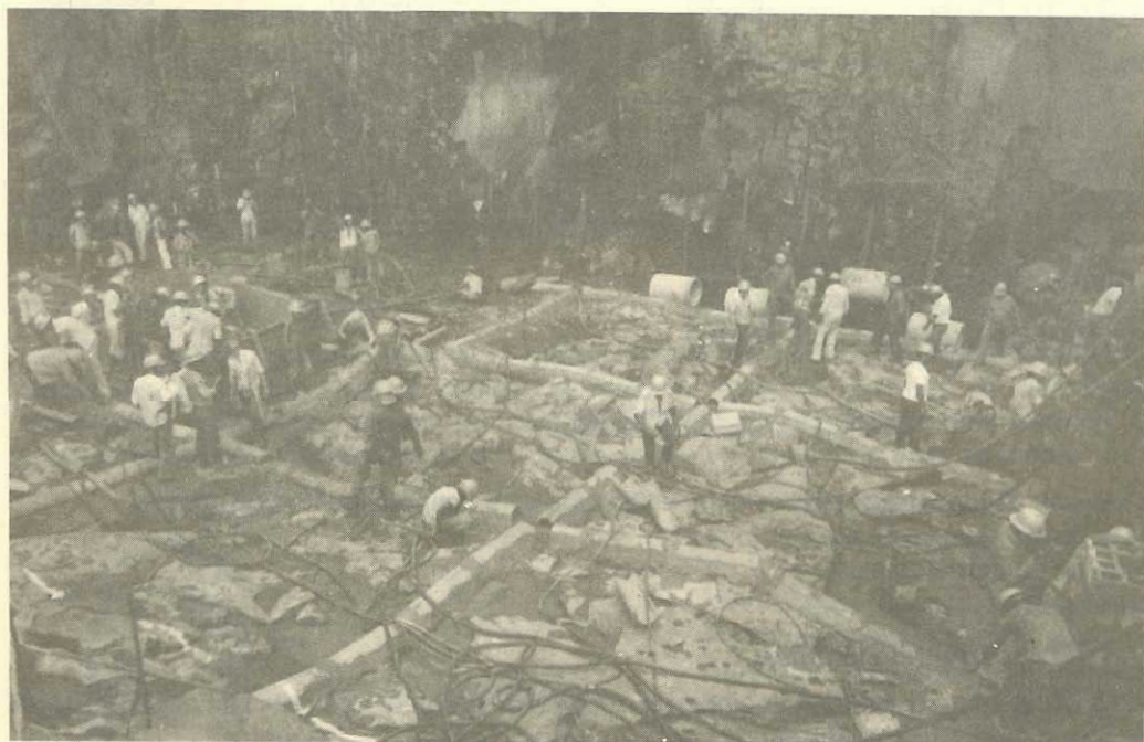
Figura 10.25 - Preparo de uma superfície de rocha para a fundação. Nota-se a malha de drenagem composta por meias-canais de concreto - Itaipu
