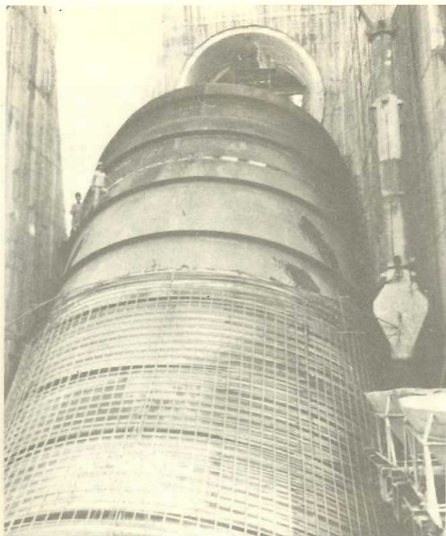
Figura 11.8 - Concreto sendo transportado de grandes alturas, aproximadamente 30 metros, por meio de tromba, com dissipadores de energia - Tucuruí
