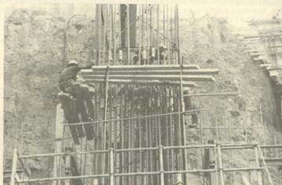
Figura 8.78 -Emendas com luvas Cadweld-Érico - Itaipu
