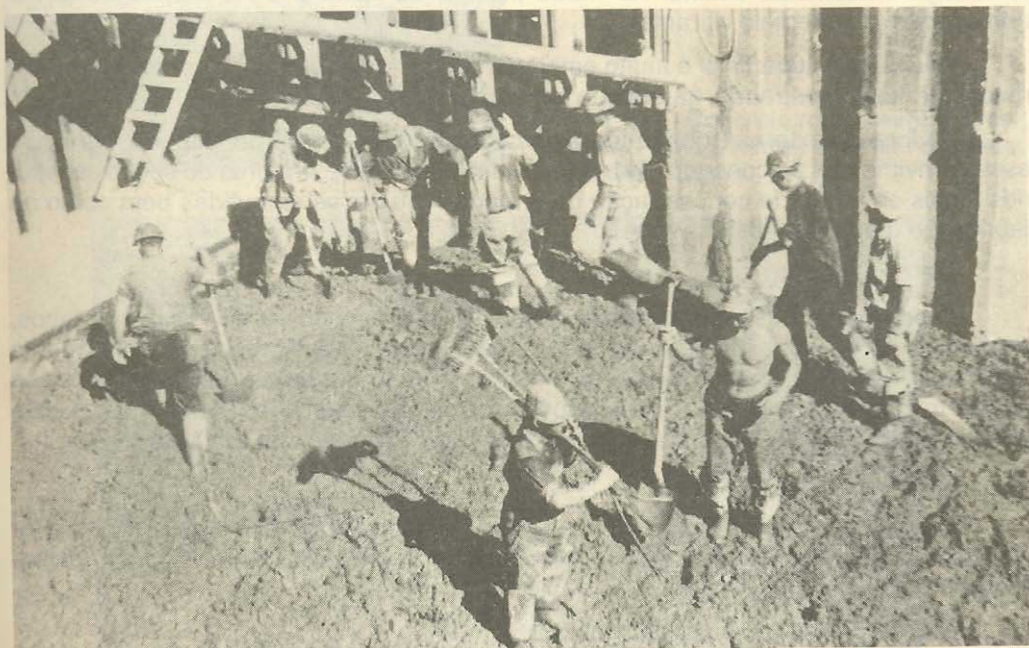
Figura 12.5 - Compactação de concreto (com trabalhabilidade de 7,5 cm) através do apiloamento com os "pés". Os vibradores eram utilizados somente nos "cantos" e extremidades de fôrmas e proximidades de embutidos [12.2]
