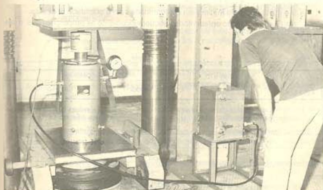
Figura 4.36 - Ensalo para Determinação dos Parâmetros Triaxiais do Concreto - Itaipu
