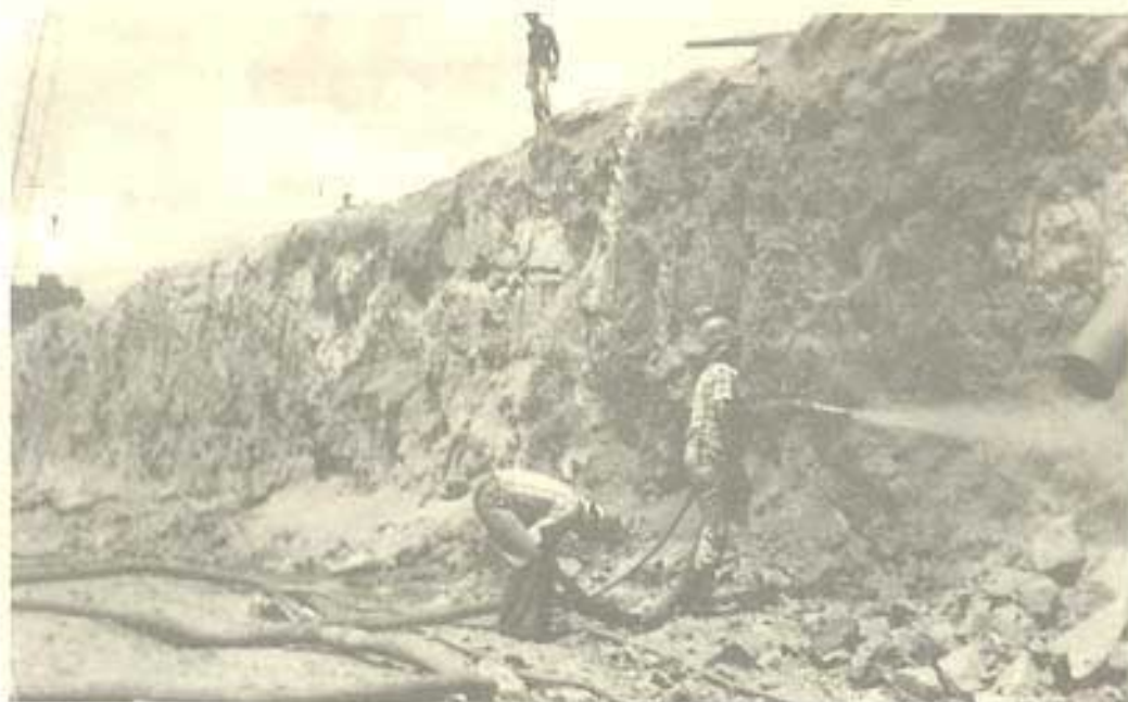
Figura 16.25 - Argamassa projetada para proteção de talude de rocha - Serviço em execução - Obra de Rosana
