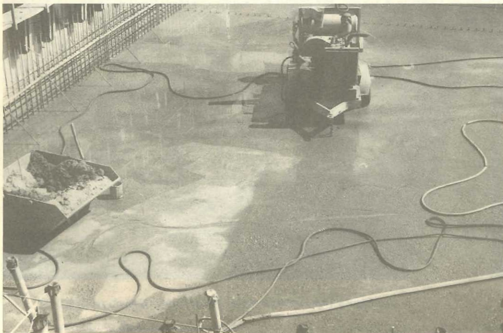
Figura 10.7 - Bomba para jato de água a alta pressão - Porto Primavera
