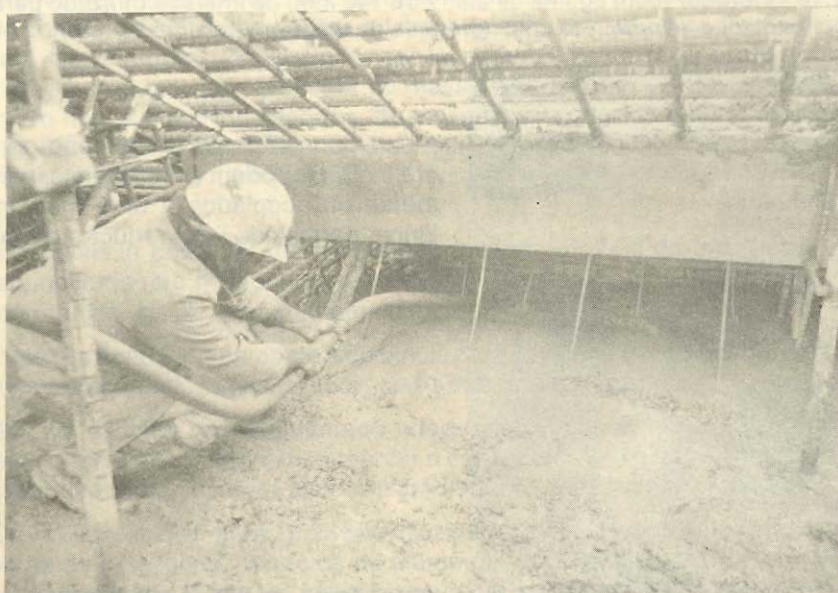
Figura 12.18 - Vibrador de mangote sendo utilizado para compactação de concreto com agregado de \phi Máx. 19 mm, em local de difícil acesso - Itaipu
