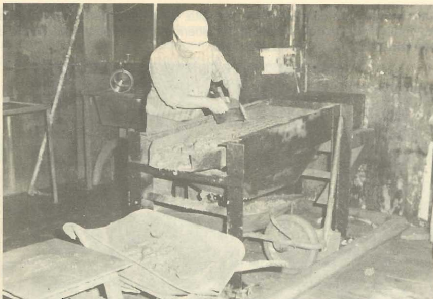
Figura 9.19 - Separação pelo peneirador de concreto, da fração superior a 38 mm, no concreto massa, para ensaios de controle durante a produção para diversas moldagens
