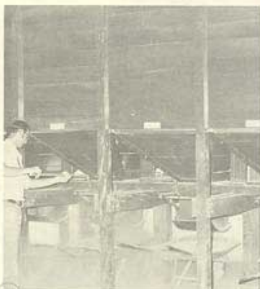
Figura 4.27 - Silos de Agregados e Aglomerantes - Sala de Dosagem - Itaipu
