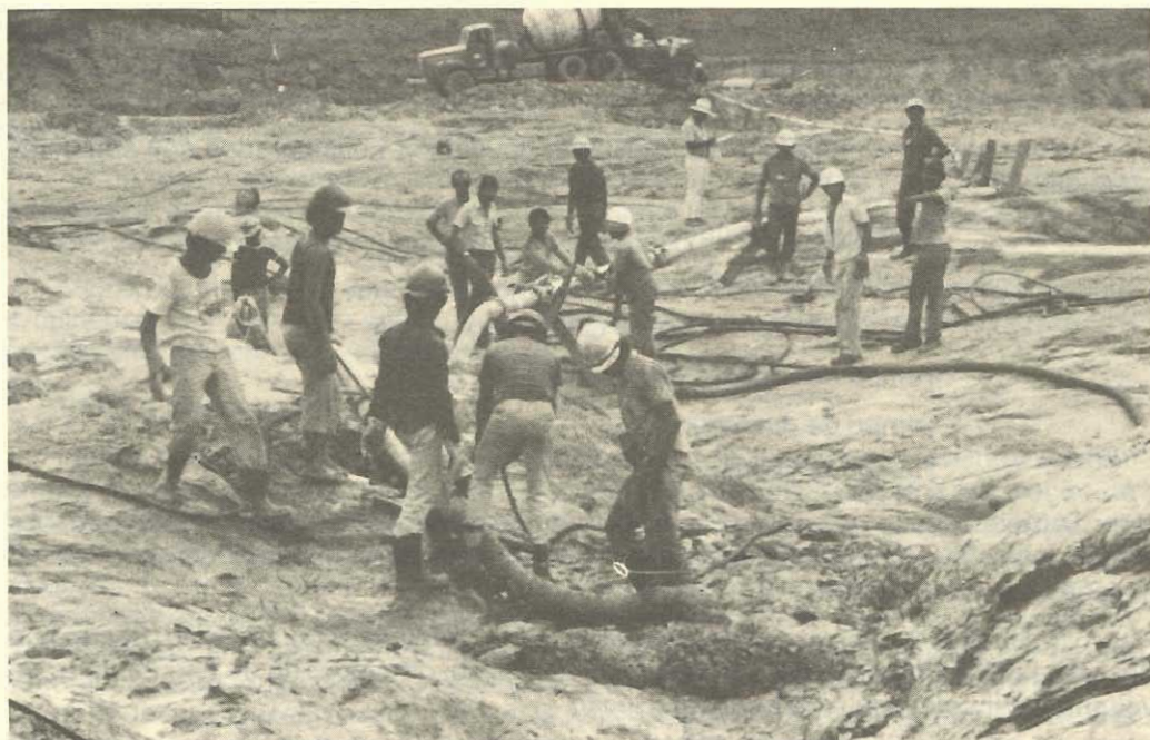
Figura 11.1 - Caminhão betoneira alimentando bomba de concreto
