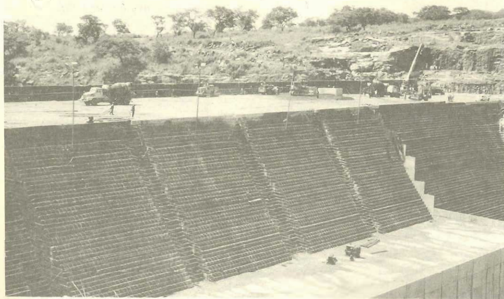
Figura 12.9 - Compactação do concreto rolado na barragem de Capanda - Angola
