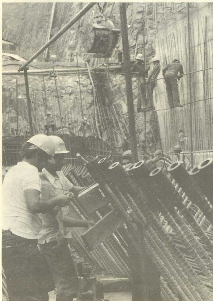
Figura 8.86 - Situação da execução de emenda prensada em armadura de espera - Itaipu
