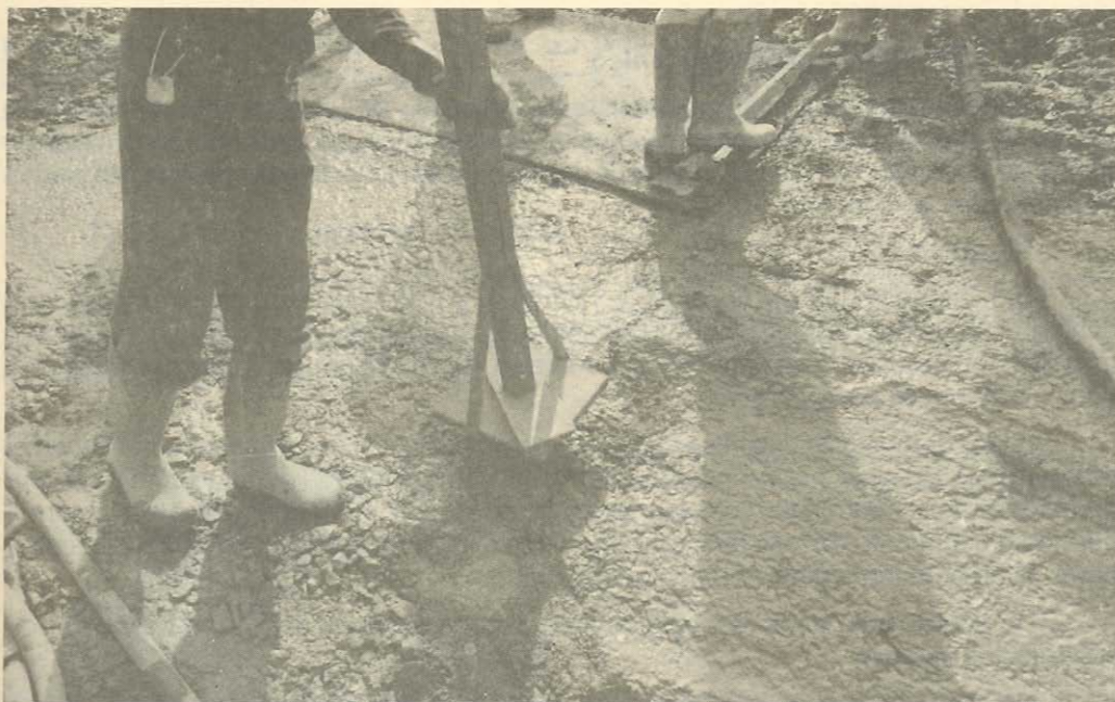
Figura 12.4 - Compactação por apiloamento, através de "soquete" de madeira, em concreto com agregado de D_{\text{Máx}} = 38 \text{ mm}
