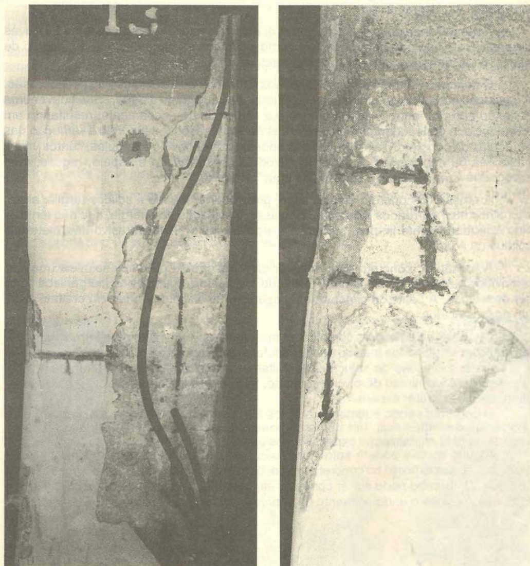
Figura 5.42 - Desagregação do concreto devido à expansão por corrosão da armadura
