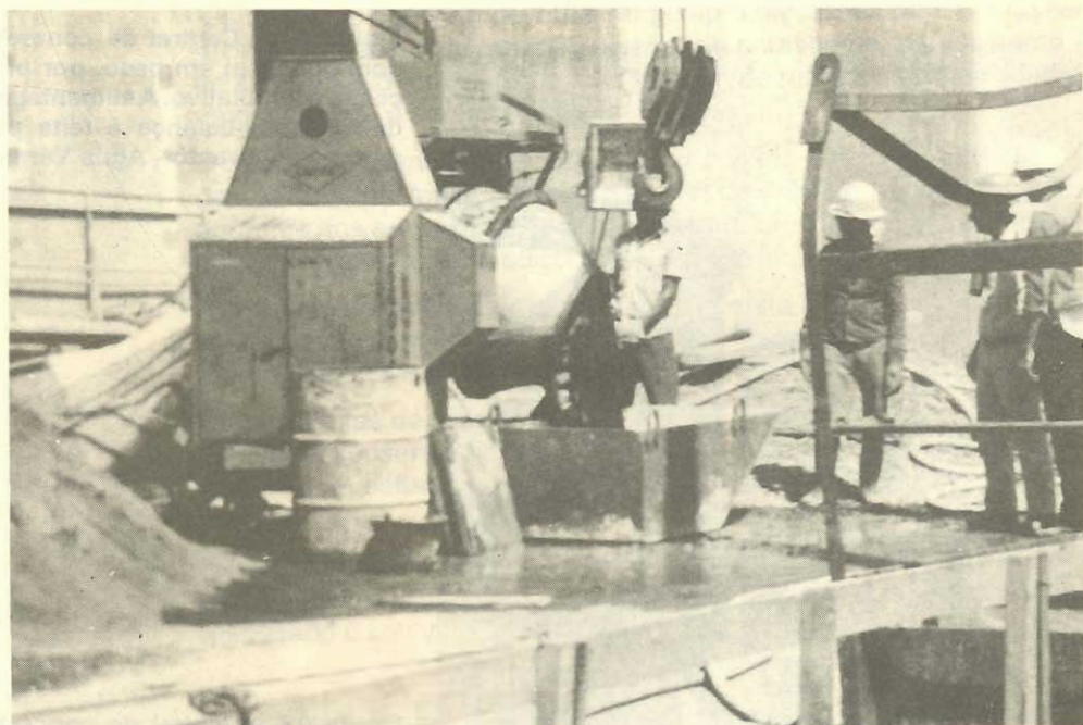
Figura 9.3 - Betoneira portátil de capacidade 500l, normalmente usada com dosagem em volume
