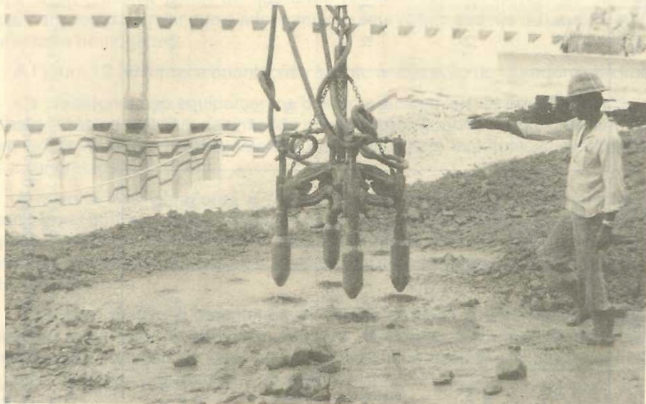
Figura 12.37 - Aspecto "vítrea" da superfície do concreto adensado - Itaipu
