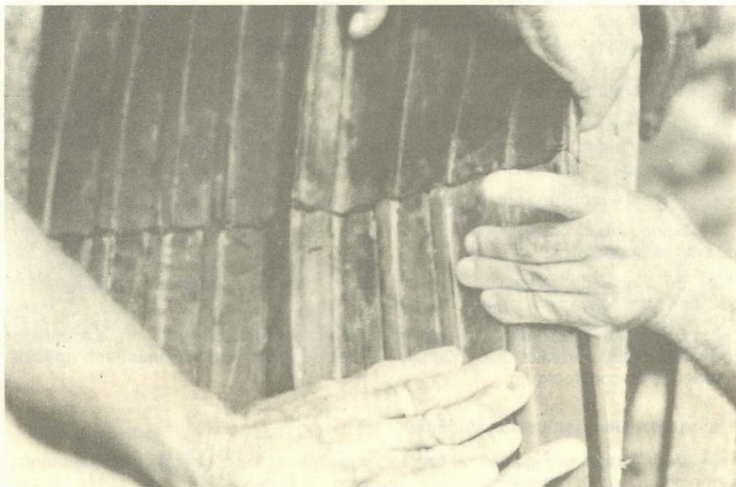
Figura 10.12 - Ligação de veda-junta após o pre-aquecimento das superfícies de contato
