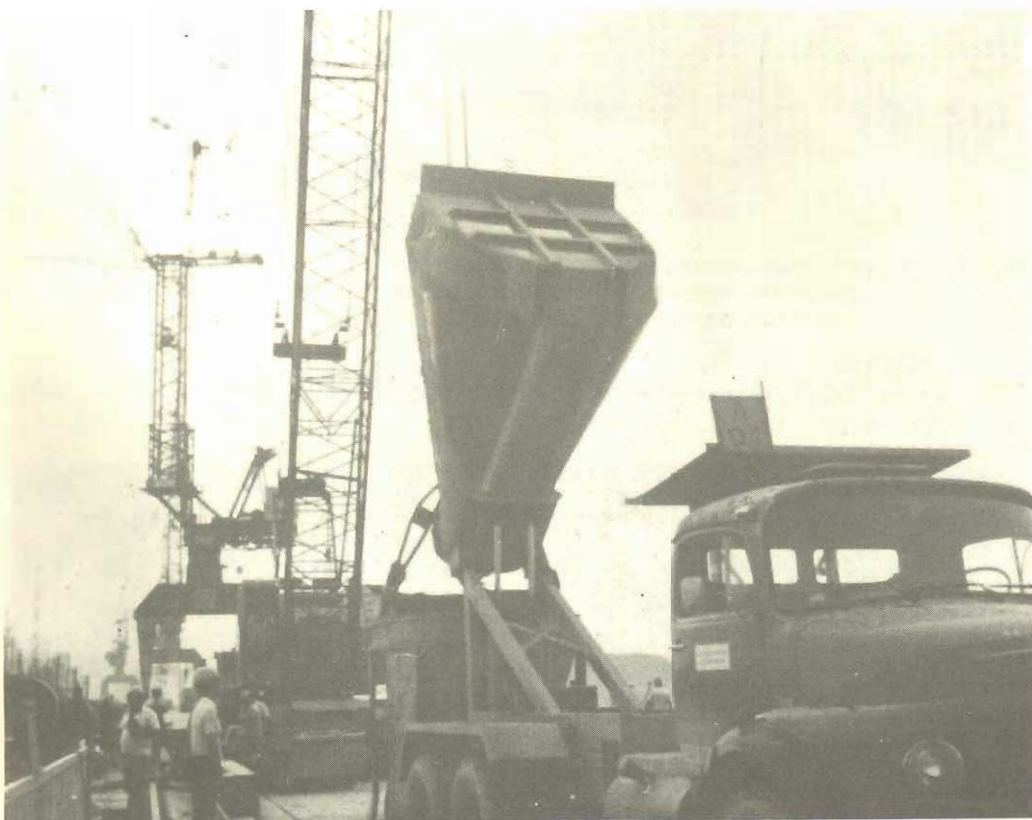
Figura 11.2 - Caminhão basculante ( 3 \text{ m}^3 ) descarregando na caçamba. Observa-se a plaqueta de identificação do concreto na frente do caminhão -Tucuruí
