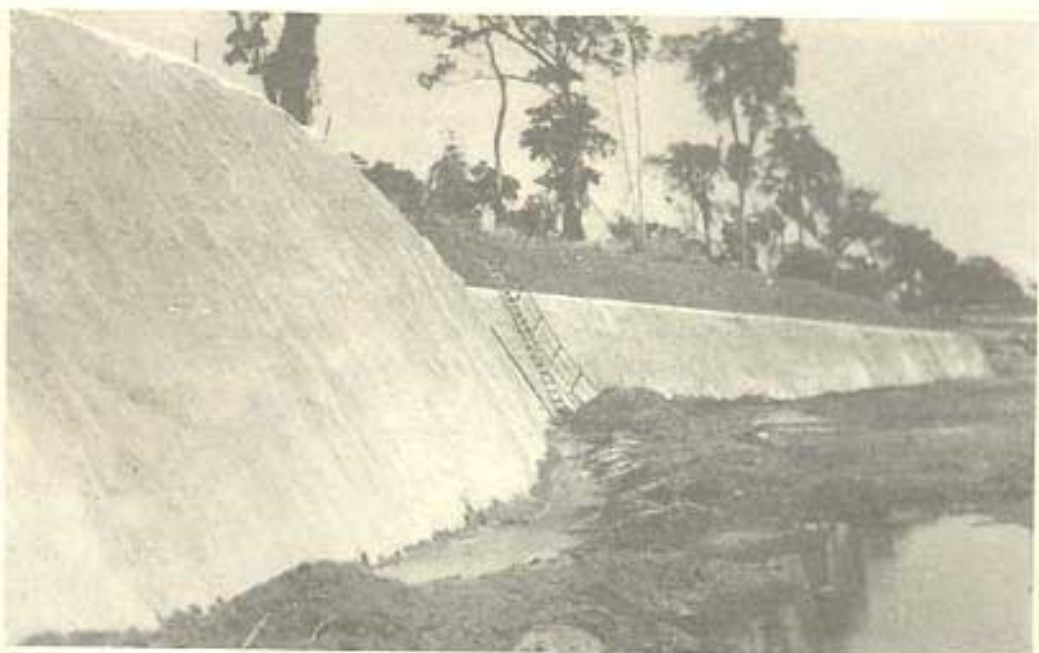
Figura 16.26 - Argamassa projetada para proteção de talude de rocha - Serviço acabado - (Ver Figura 16.25) - Obra de Rosana
