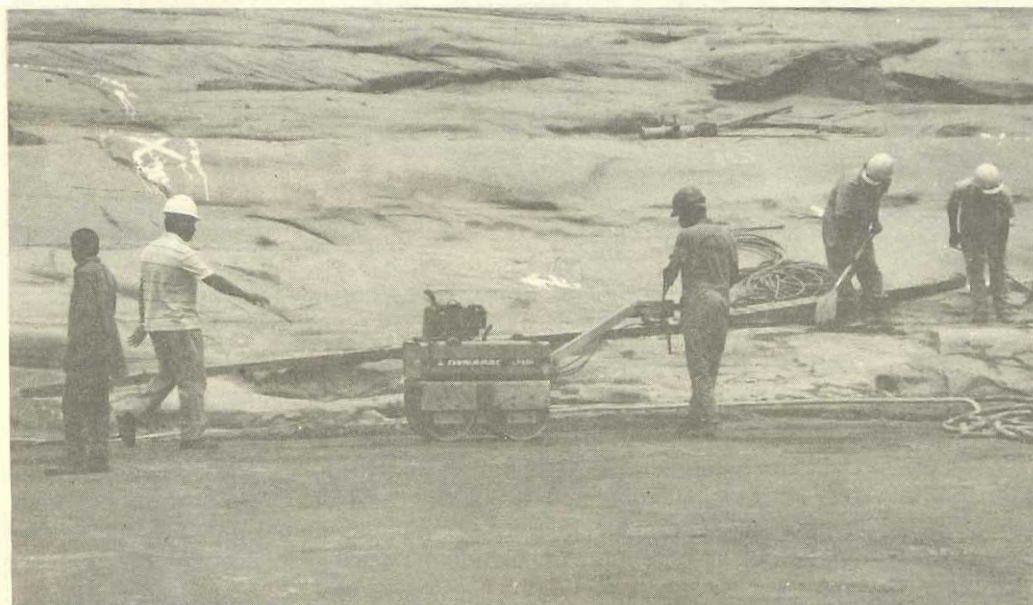
Figura 12.11 - Compactação sendo executada por rolos vibratórios de pequeno porte - Capanda - Angola
