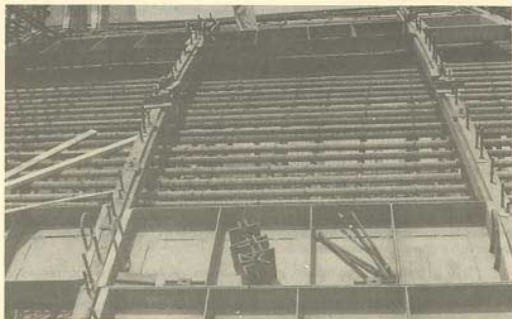
Figura 12.48 - Fôrma temporariamente fixa com painéis metálicos - Itaipu
