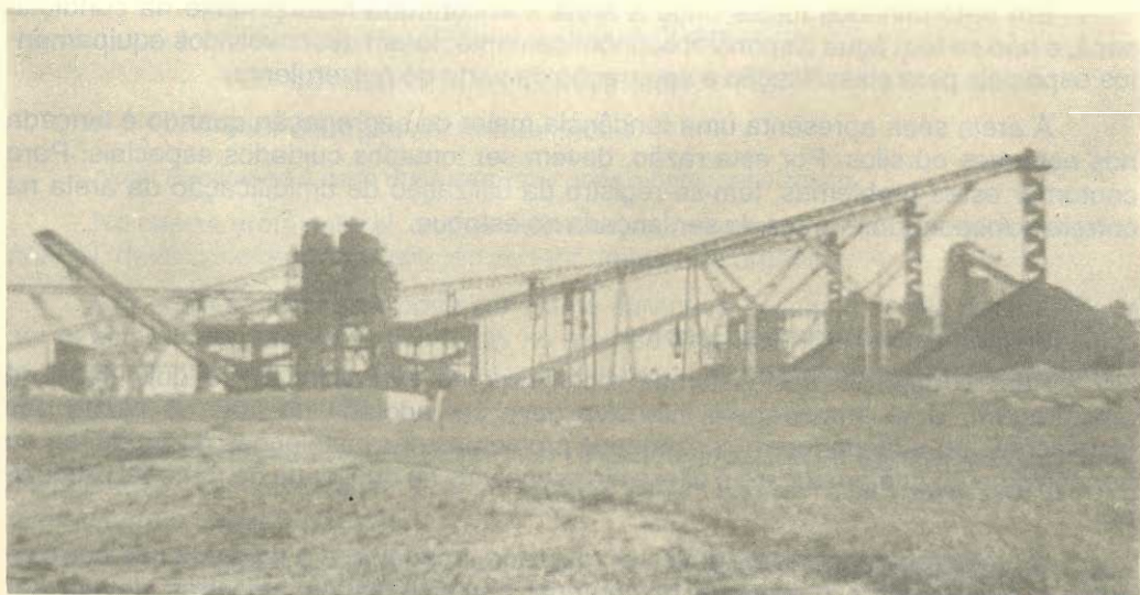
Figura 8.33 - Sistema completo de beneficiamento de agregado natural, notando-se à direita os dispositivos para evitar a queda livre do material - Rosana
