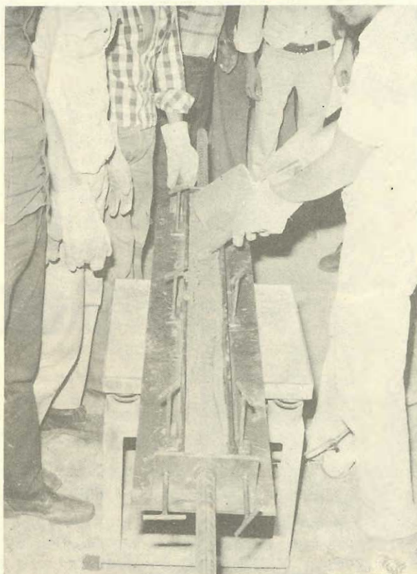
Figura 12.32 - Fôrma vibratória, para adensamento de concretos pré-moldados
