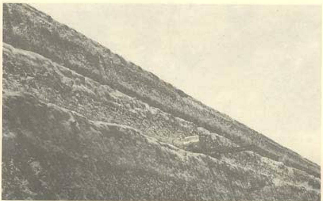
Figura 16.28 - Concreto projetado aplicado como proteção definitiva - Canal Pereira Barreto - CESP
