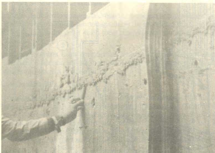
Figura 10.33 - Concreto poroso e descontinuidade na superfície, devido a má fixação e vedação do "pé" do painel, propiciando vazamento de argamassa
