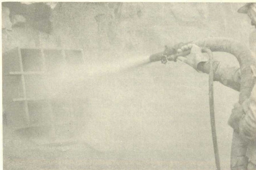
Figura 12.16 - Moldagem de amostra de concreto projetado (ver Capítulo 16)
