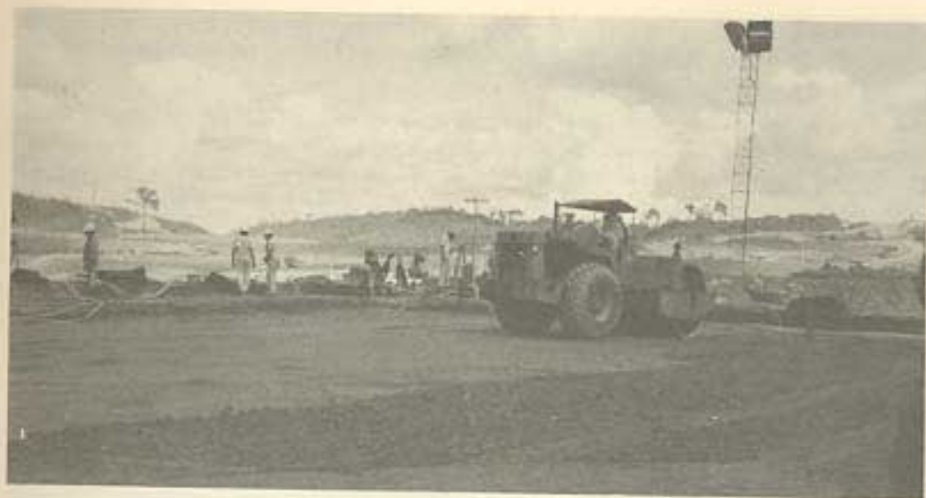
Figura 16.14 - Aplicação do concreto adensado com rolo vibratório, em estruturas permanentes, pela primeira vez no Brasil - Abril 1982 - Eclusas de Tucuruí - Eletronorte
