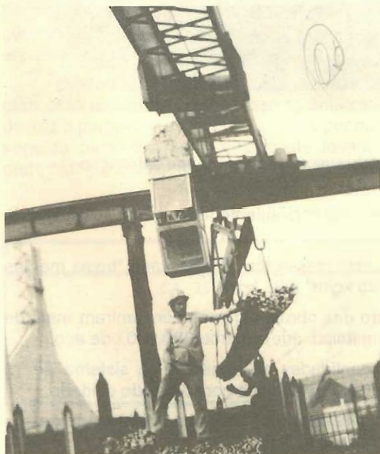
Figura 8.46 - Ponte rolante armazenando feixe de barras nas baias do estoque de aço bruto - Itaipu
