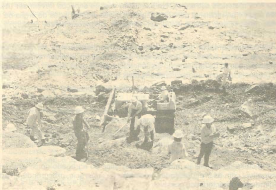
Figura 10.1 - Preparo de fundação em rocha para o mapeamento geológico e posterior liberação. Observa-se o emprego de máquina (Bulldozer) e ferramentas manuais - Itaipu
