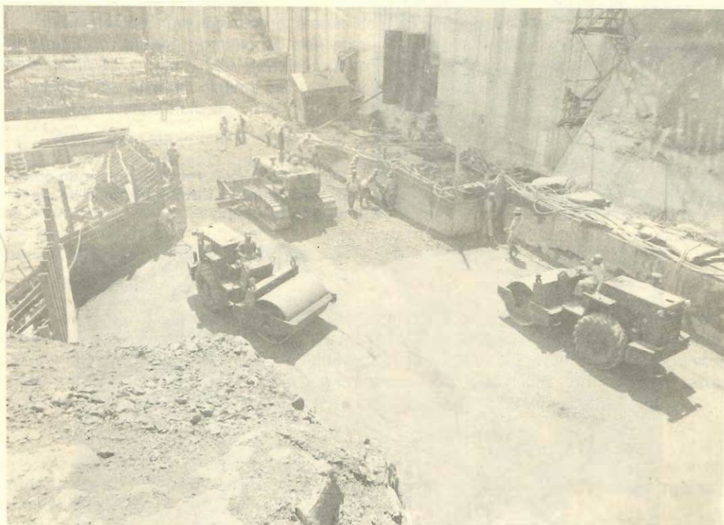
Figura 12.8 - Compactação de concreto por meio de rolo vibratório liso - Itaipu
