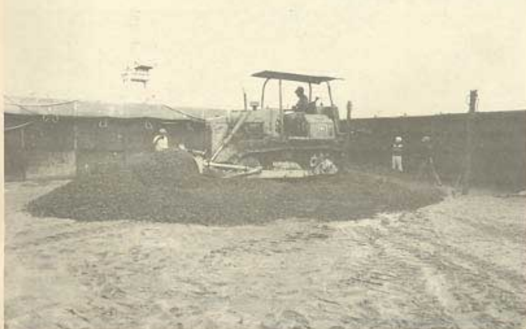
Figura 16.18 - Espalhamento e compactação do CCR, nos blocos da cabeça da Eclusa - Tucuruí
