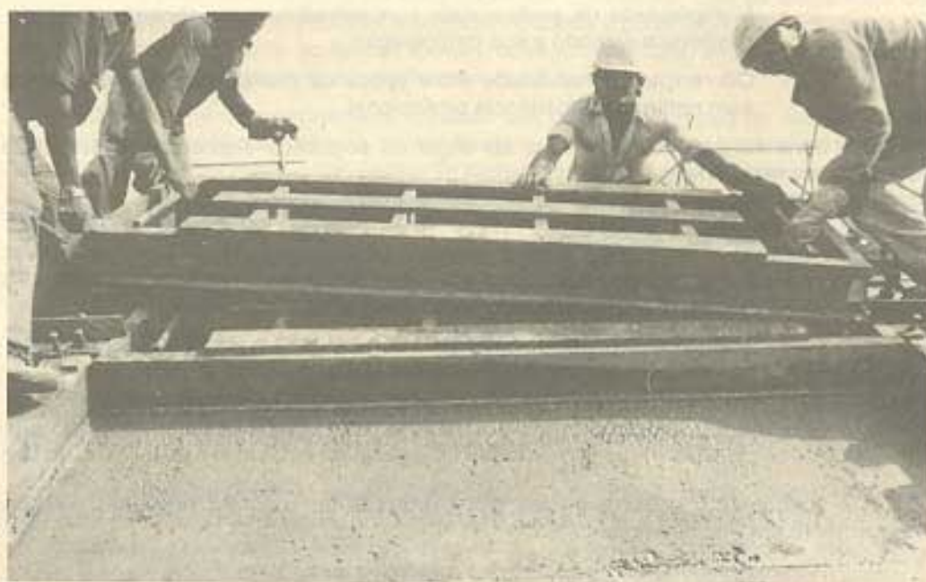
Figura 12.49 - Fôrma temporariamente fixa com painéis em madeira compensada - Tucuruí
