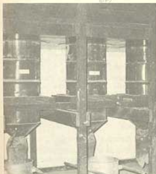
Figura 4.27 - Silos de Agregados e Aglomerantes - Sala de Dosagem - Itaipu
