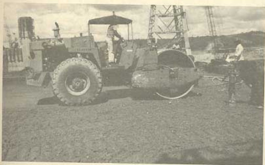
Figura 16.15 - Adensamento do concreto, pela ação do rolo vibratório liso-Tucuruí.
