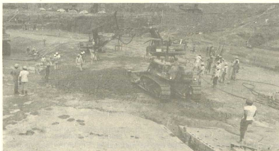
Figura 11.25 - Colocação do concreto através de caminhões basculante fora de estrada, sendo o adensamento efetuado por vibradores acoplados a uma retroescavadeira - Itaipu
