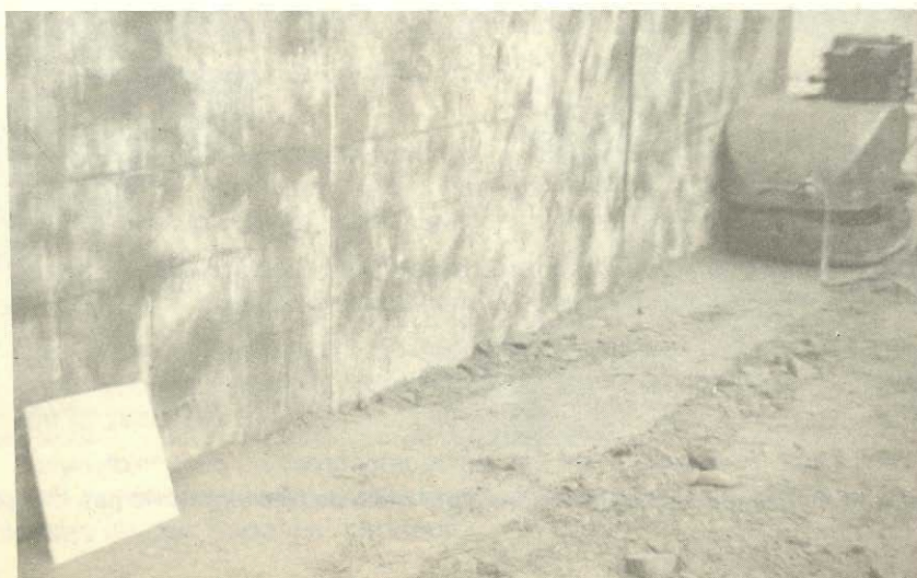
Figura 12.7 - Concreto rolado sendo compactado (junto à fôrma) por meio de placa vibratória - Itaipu
