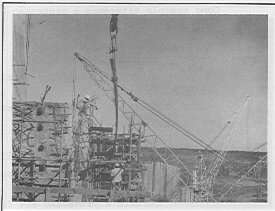
Fotografia 38 - Colocação do cabo longitudinal com auxílio do guindaste.
