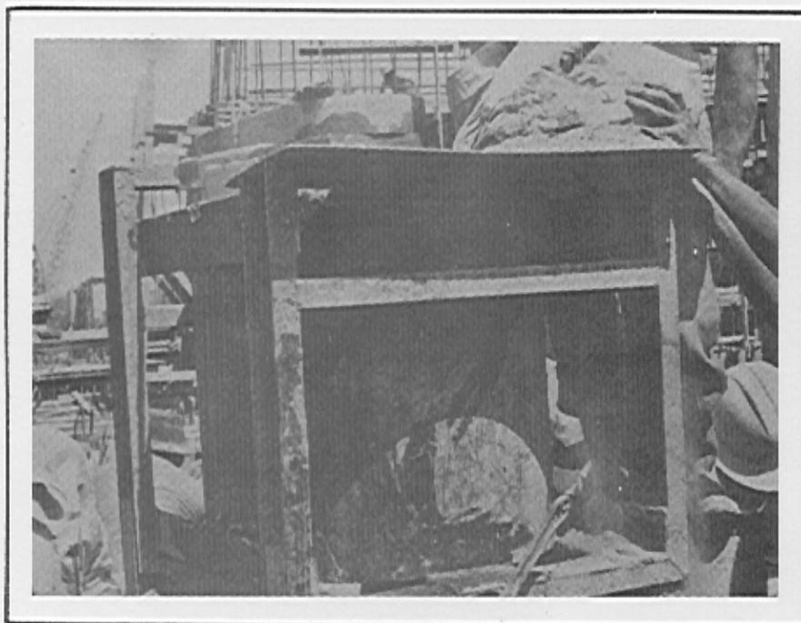
Fotografia 72 - Misturador de alta rotação.
