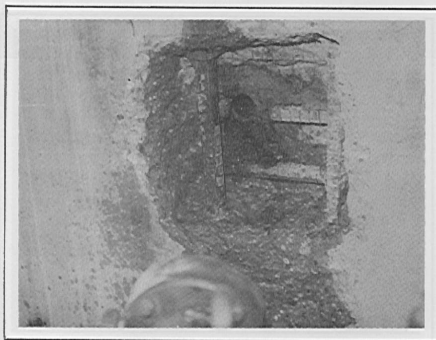
Fotografia 71 - Furo executado ( $\varnothing = 2 \frac{1}{2}$ " ) - até atingir a bainha do cabo vertical -50 do PV - 6.
