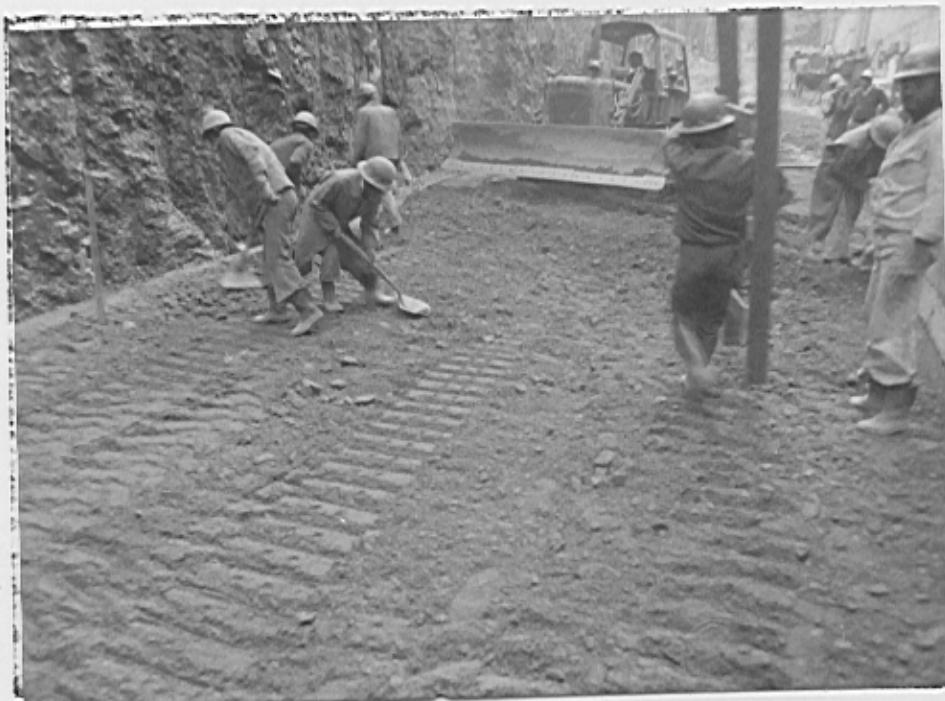
Foto XVI - Instante de término de nivelamento de mais uma subcama da. À esquerda vê-se uma estaca orientativa da cota de nivelamento da subcamada. Vê-se ainda funcionários usando pás e enxadas para eliminar pontos eventuais de segregação ("ninhos" de pedra).
