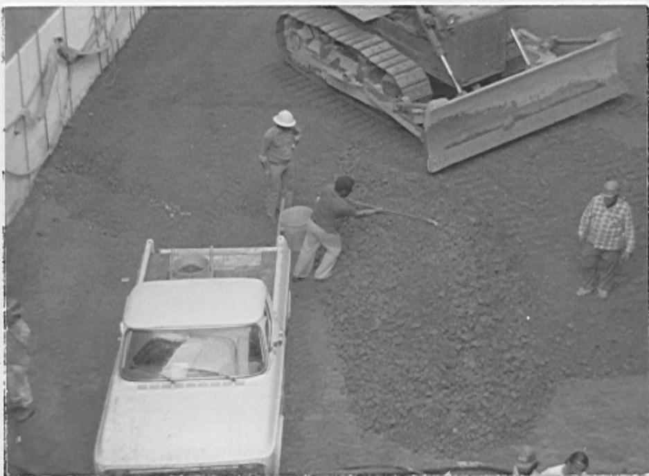
Foto XI - Coleta de amostras no local de lançamento, para ensaios de Laboratório.
