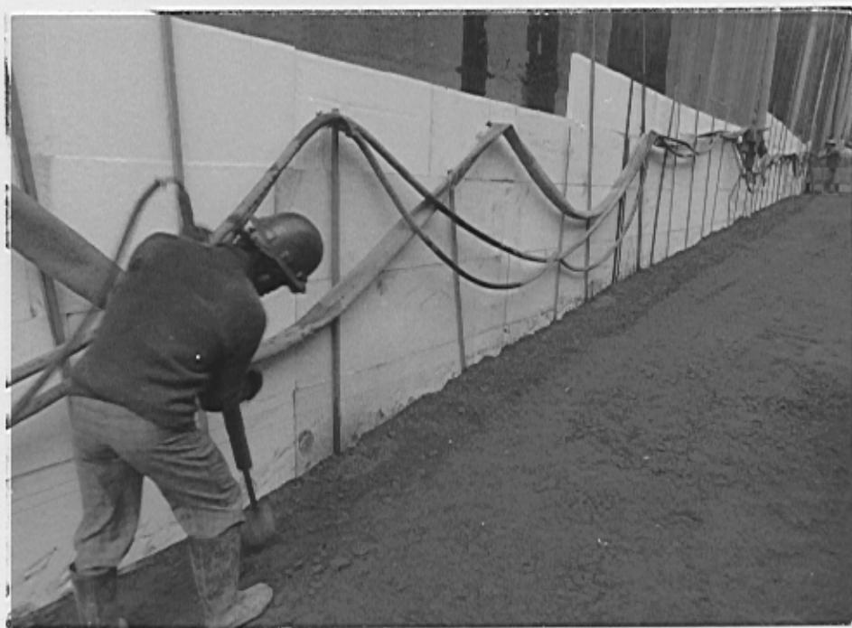
Foto XIX - Região sendo compactada por meio de compactador portátil tipo "perereca" tipo SP-5 da Brobrás, peso 15,5 kg com 500 impactos por minutos.
