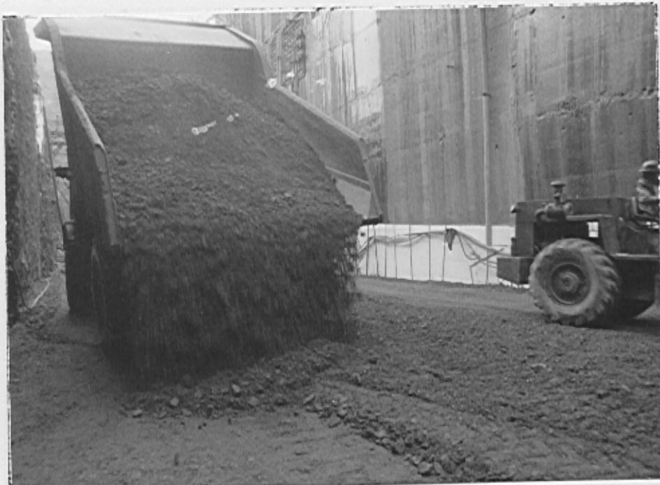
Foto XIV - Instante de basculamento de um "Fora-de-Estrada", sobre concreto já anteriormente adensado. Nota-se o aspecto "arenoso" da mistura.
