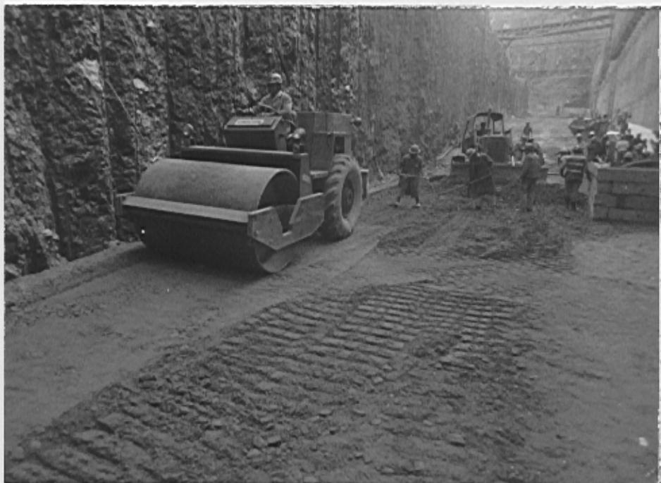
Foto XVII - Execução do adensamento do "Rollcrete" através da utilização do rolo vibratório tipo CA-15 (DYNAPAC). É interessante notar nesta foto ainda (entre o talude rochoso e o tambor compactador) uma pequena "ensecadeira" feita com concreto convencional, destinada a drenar água de infiltração do talude. Nota-se ainda, operários procurando eliminar pontos de segregação, operação esta executada imediatamente após o espalhamento e antes da compactação.
