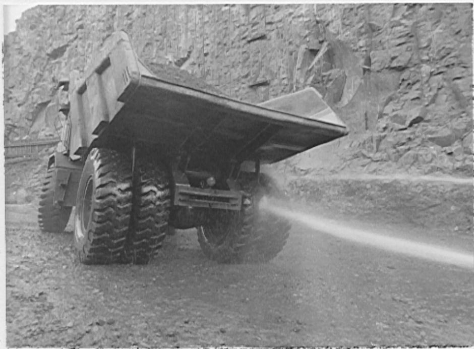
Foto XIII- Limpeza dos pneus dos caminhões "fora-de-estrada" imediatamente antes da entrada na região do lançamento.
