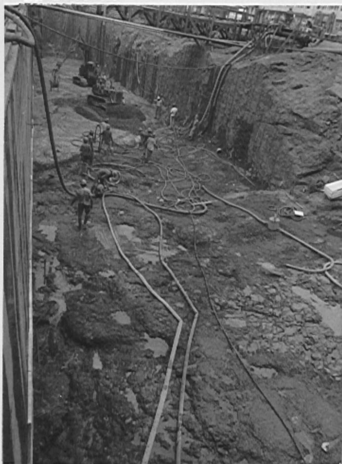
Foto X - Concretagem de regularização. O concreto usado foi de diâmetro máximo 76 mm com trabalhabilidade (slump)  $3 \pm 0,5$  cm. O lançamento foi executado com guindastes e cabos aéreos e o adensamento com vibradores convencionais de imersão.
