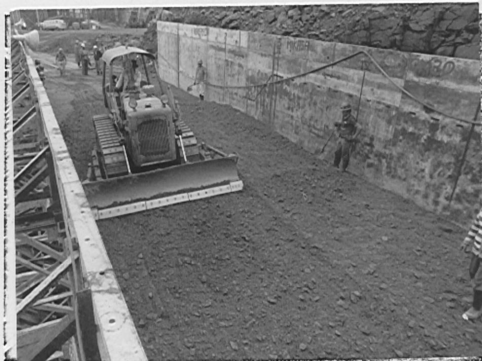
Foto XXVIII - Início de execução do aterro experimental. Chama-se atenção para a homogeneidade da mistura.
