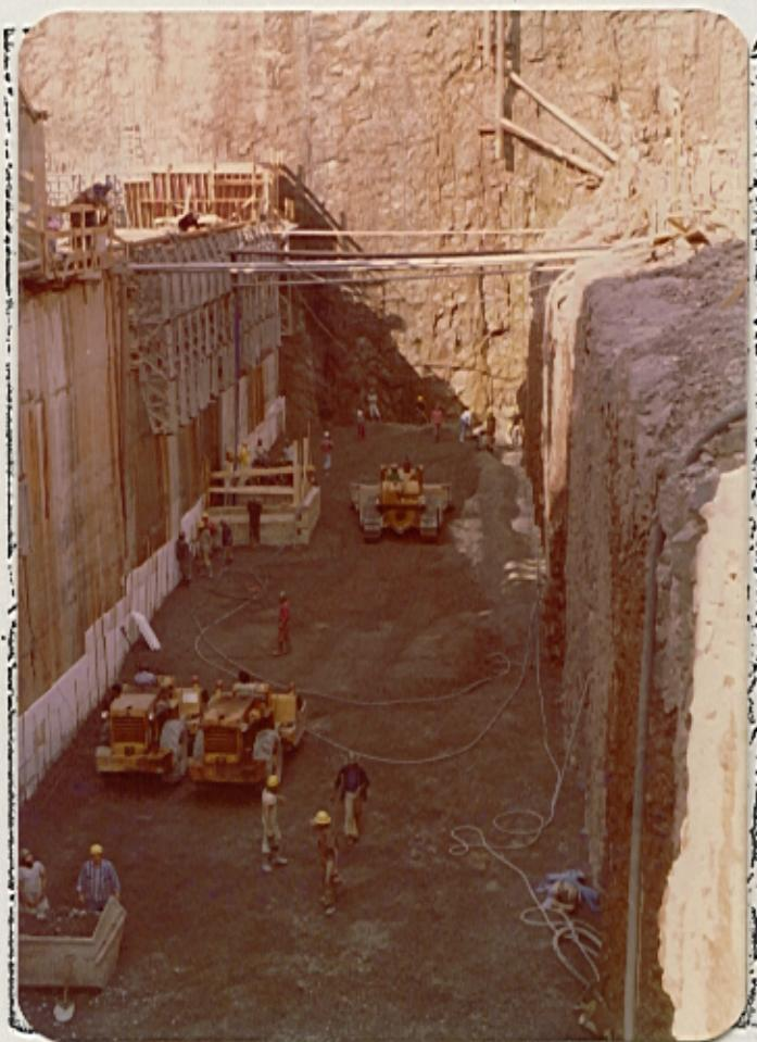
Foto XX - Vista geral do local de trabalho, observando-se o caminhão "Fora-de-Estrada" em término de basculamento da mistura, o trator de lâminas indo em direção ao material basculado, para espalhamento, e o rolo compactador efetuando o adensamento das subcamadas niveladas. Em primeiro plano observa-se ainda a execução de limpeza de fundação.
