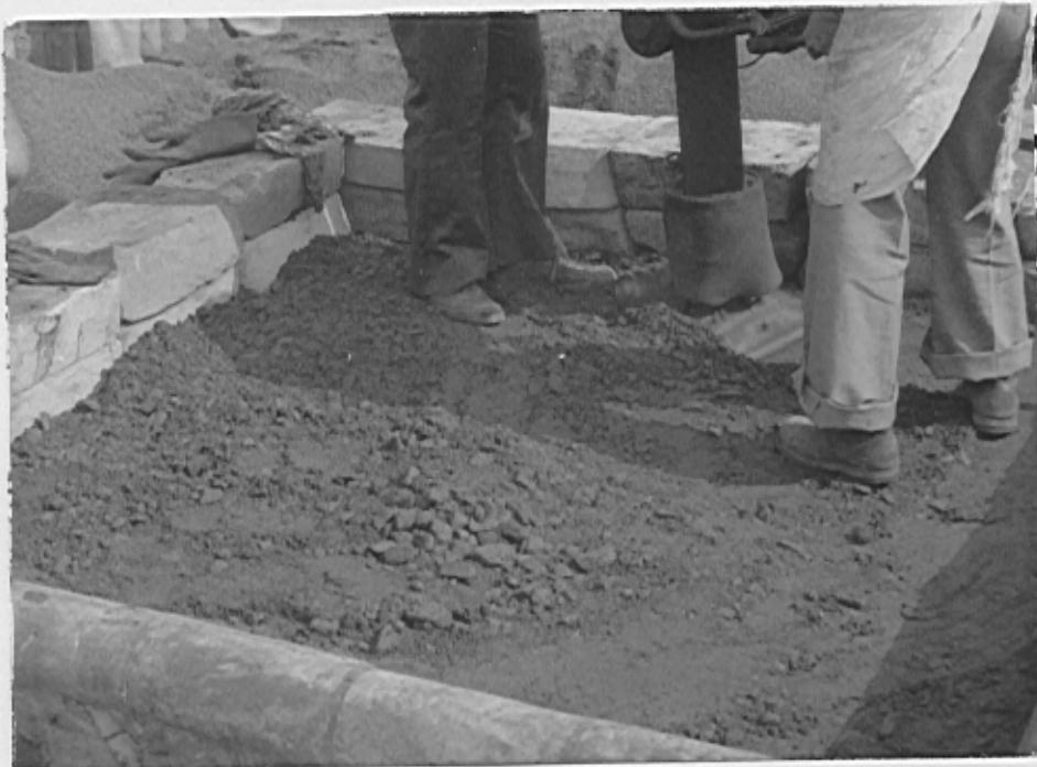
Foto VII - Área de ensaio, no Laboratório, sendo adensada com compactador portátil.
