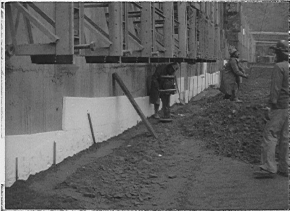
Foto XVIII - Região de contacto da face jusante da Estrutura de Desvio com o "Rollcrete", sendo adensada por meio de compactadores portáteis (sapo) - Modelo MTR-80 H, da Milkasa, com as características descritas na foto VII
