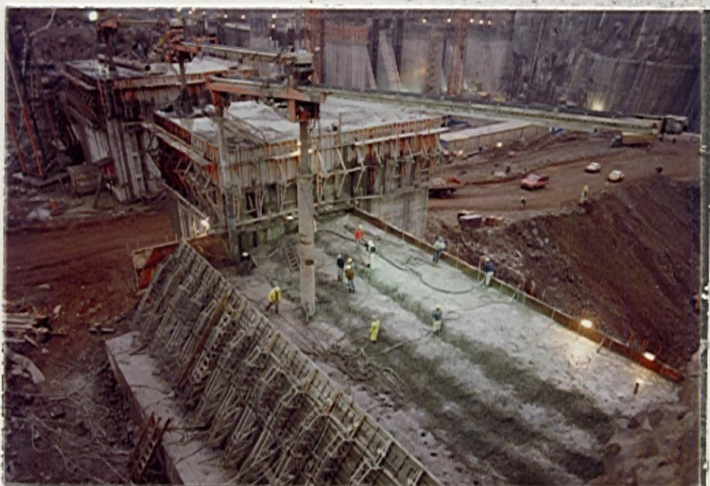
Figura 24: Utilização de correias transportadoras para concreto massa com Ø max 76 mm em locais fora do alcance dos guindastes e cabos aéreos.
