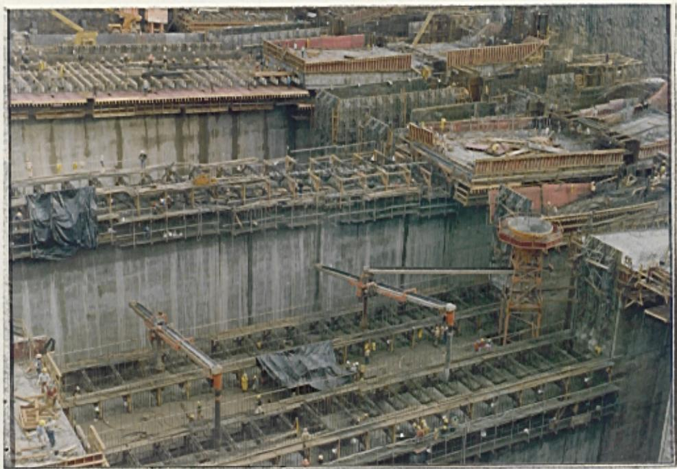
Figura 25: Uso de esteiras para concretagens com formas deslizantes.
