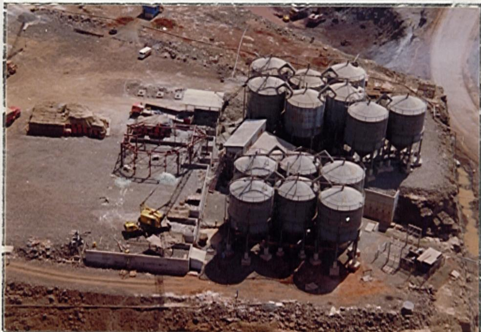
Figura 11: Vista do sistema de ensilagem de aglomerantes, durante sua montagem na Margem Esquerda.
