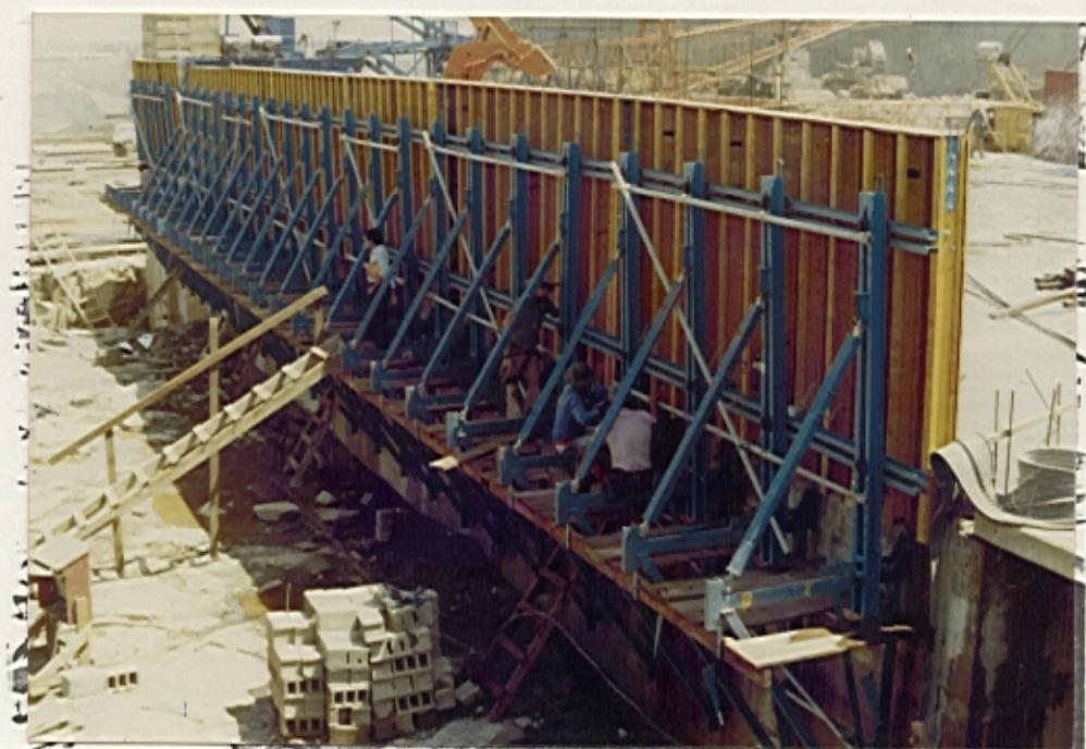
Figura 34: Formas com montantes metálicos (não articulados) e complementos de madeira.
