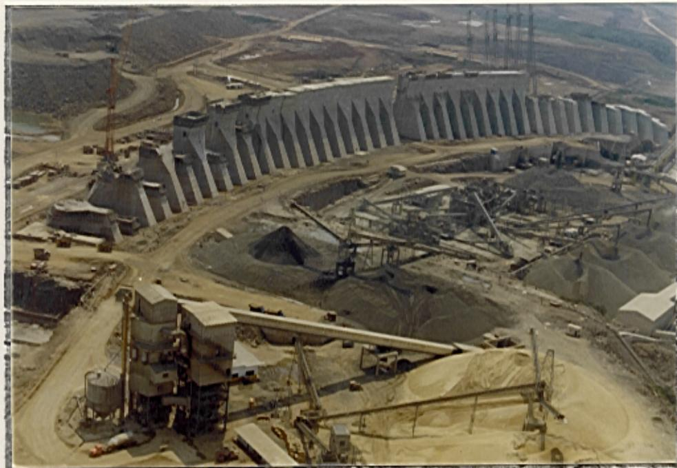
Figura 17: Central nº 6 e sistema de britagem da Margem Direita.
