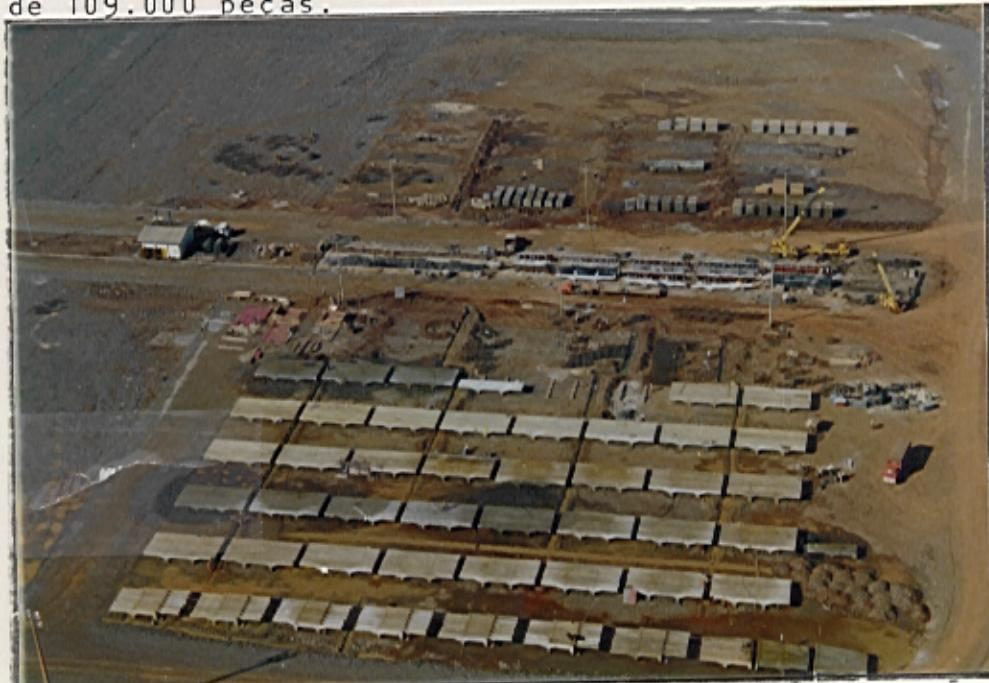
Figura 35: Vista do sistema de fabricação de pré-moldados da margem esquerda.
