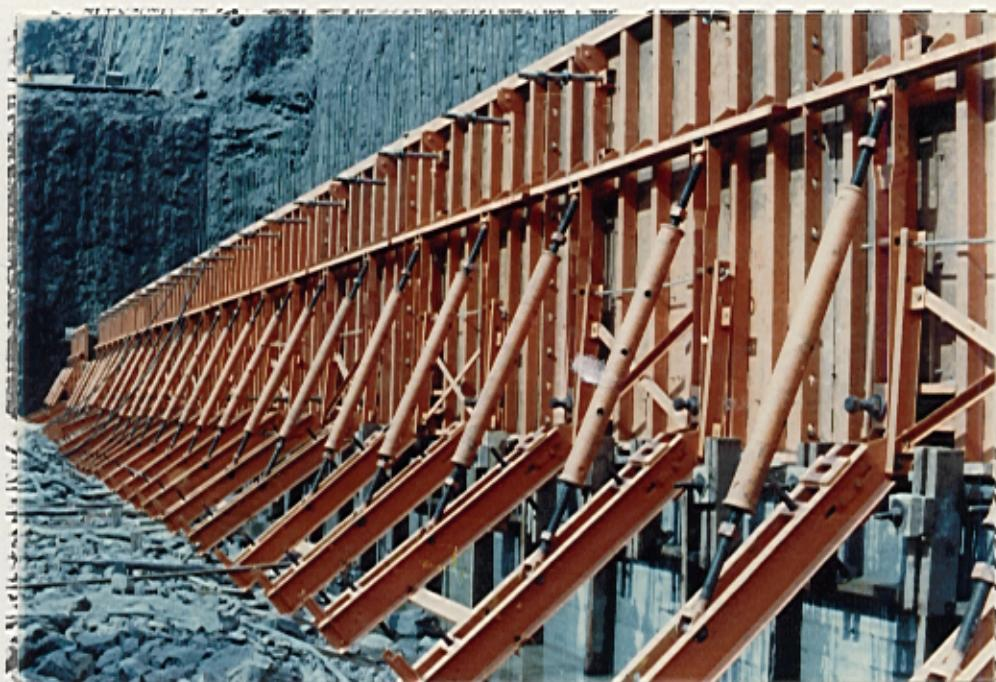
Figura 33: Forma com estrutura e painel metálicos.
