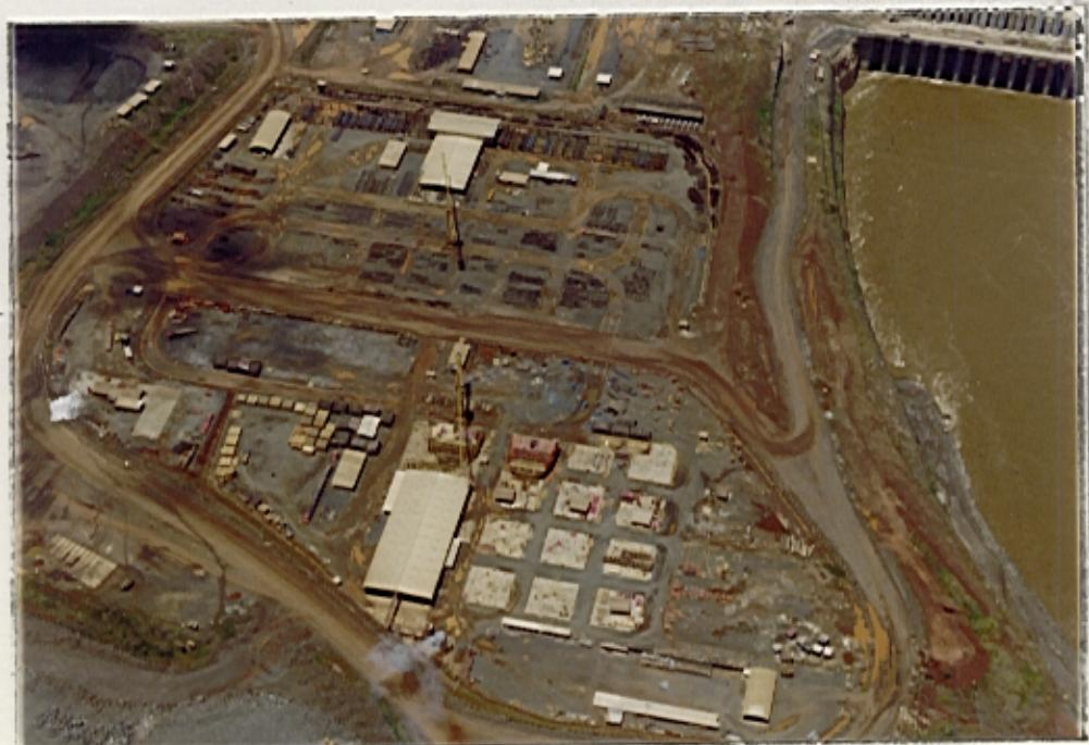
Figura 27: Vista dos pátios de Carpintaria (primeiro plano) e armação (segundo plano) da Margem Esquerda.
