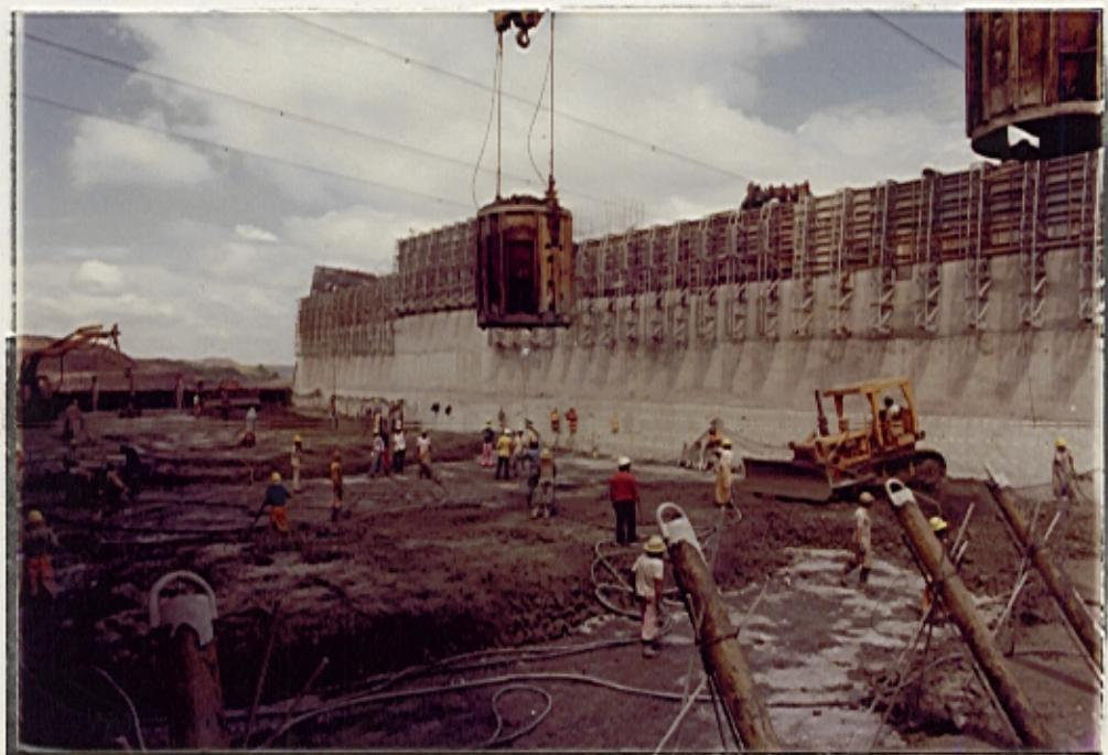
Figura 26: Lançamento de concreto com cabos aéreos (4) auxiliados por "bulldozers" (2) para espalhamento do concreto e adensamento por meio de vibradores acoplados à retro-escavadeiras (2), em uma frente de concretagem de  $L = 72,0\text{ m}$ ,  $W = 24,6\text{ m}$  e  $H = 2,5\text{ m}$ , tendo sido aplicados aproximadamente  $4.500\text{ m}^3$  de concreto em 12 horas.
