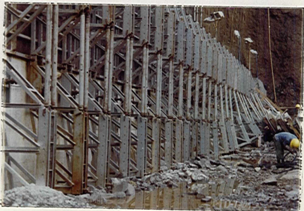
Figura 32: Forma com estrutura metálica e painel em madeira compensada. A estrutura dos montantes é articulada, permitindo adaptações do apoio.
