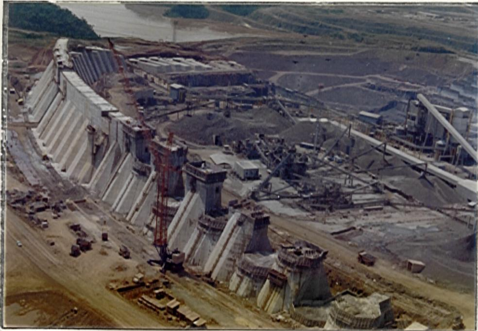
Figura 13: Sistema de britagem e centrais de concreto (4 e 5) da Margem Direita, a jusante da Barragem Lateral Direita.
