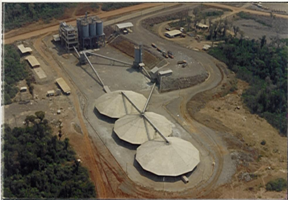
Figura 10: Instalações de moagem na Margem Esquerda. Em primeiro plano os depósitos de clinquer e ao fundo silos para cinzas volantes e cimento moído, bem como o sistema de moagem.
