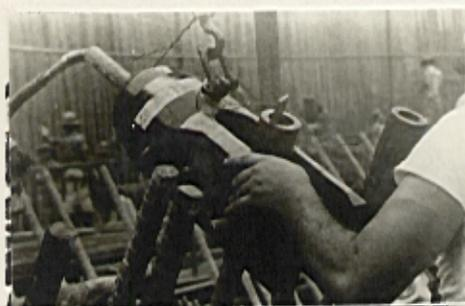
Figura 7: Execução, na Obra, de Emenda com Luva Prensada
