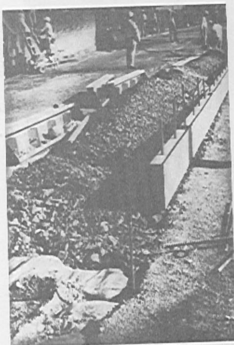
Foto Nº 13 - Galeria sendo executada com formas metálicas.
