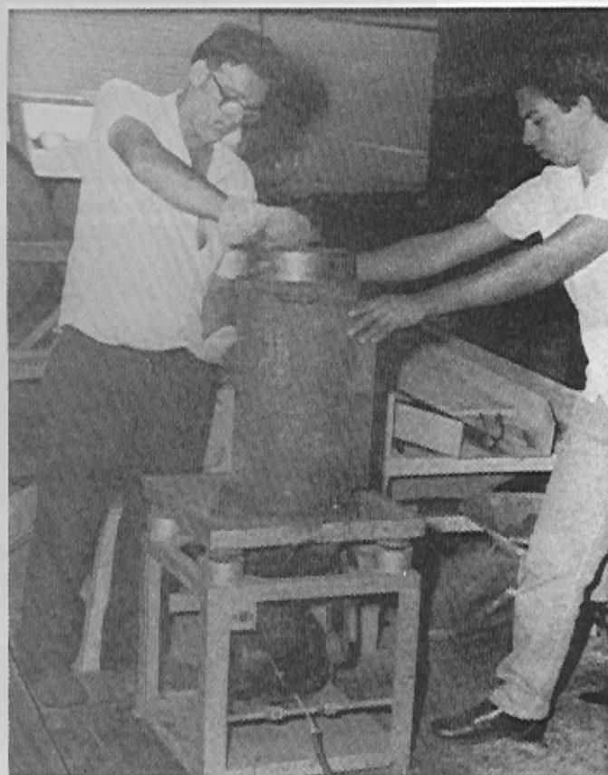
*Figura 06 - Moldagem de um corpo de prova de 25x50 cm, através da mesa vibratória e utilizando um peso de 23 kg sobre a superfície do concreto.*
