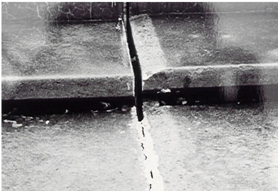
**Figura 06- Junta aberta, após o corte e liberação das deformações – Estados Unidos**
