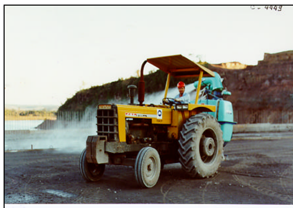
Figura 02- Trator com aspersor agrícola, adaptado para a cura.
