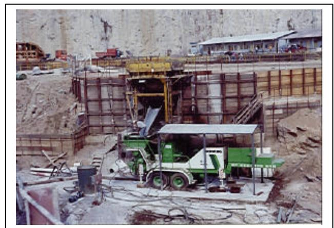
Algumas bombas recentes, com tubulação de 200mm de diâmetro permitem bombear concreto com agregado de tamanho máximo de até 75 mm, com abatimento a partir de 60mm, e teor de aglomerante inferior a 240 kg/m. Sistema
