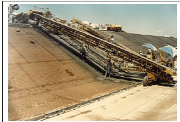
Por ser uma metodologia de avanço contínuo, requer que o Planejamento considere uma alimentação contínua como exige a boa prática. Os detalhes de conformação de juntas de contração, transições de geometria são detalhes a requerem atenção. A utilização desses equipamentos para concretagens de taludes de canais, ou rampas, exige também a adequada trabalhabilidade e consistência do concreto, bem como a adequação do Tempo de Pega e a velocidade de avanço da máquina e do acabamento.
