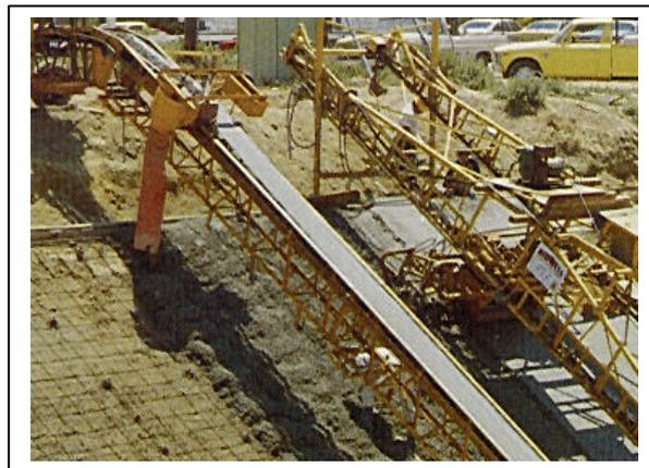
O avanço rápido desses equipamentos, não compatibilizado com o Tempo de Pega do concreto, bem como o inadequado adensamento, quando usado para moldagens de defensas ou muretas armadas, podem provocar fissuras que se identificam com a posição das armaduras.
