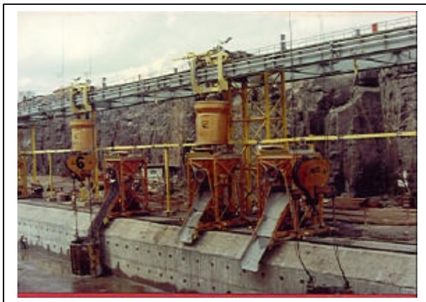
De outro modo, ainda, o posicionamento para carga, e alimentação da caçamba, no cais de alimentação. É comum se adotar um silo móvel de transferência para contornar essa dificuldade.
