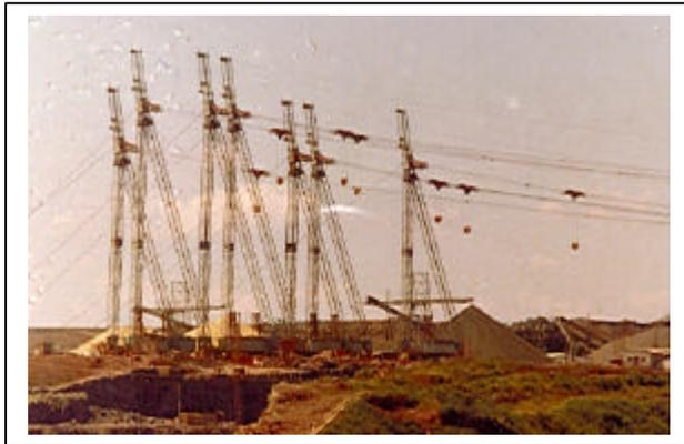
Esses detalhes são contornados pelo emprego conjunto do cabo aéreo e tratores de lâmina frontal, para permitir o espalhamento do concreto na frente de lançamento. Dessa maneira o tempo de posicionamento da caçamba no bloco é minorado, aumentando a produção.
