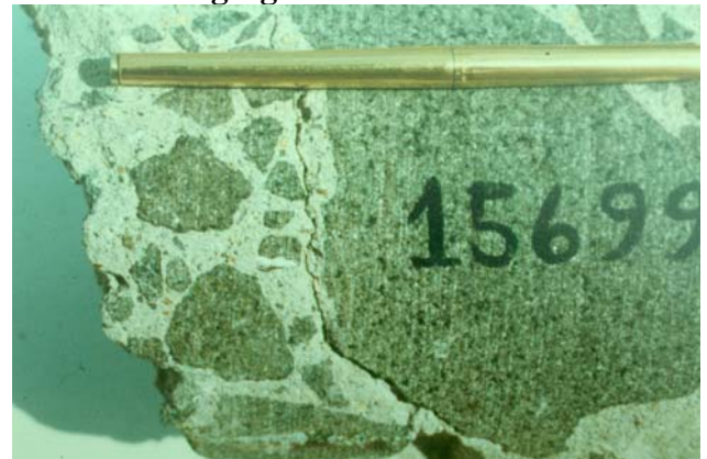
Figura 10- Fissura ao redor do agregado
