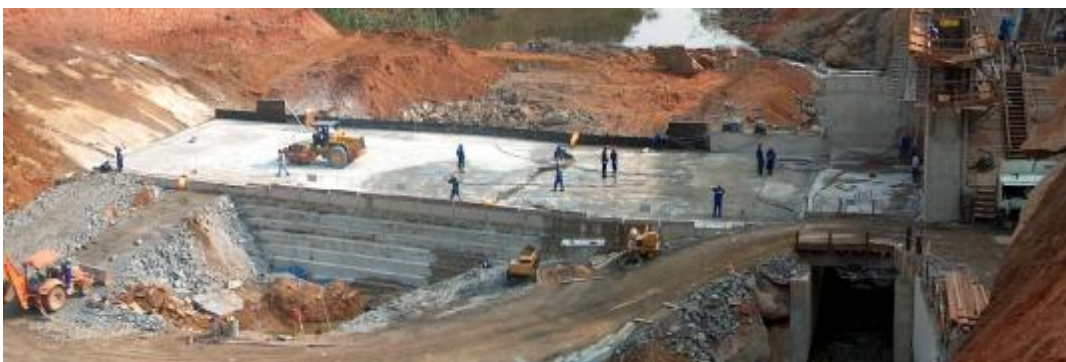
Fig. 3 Picada RCC dam, general overview from downstream Barrage BCR de Picada, vue générale de l'aval
