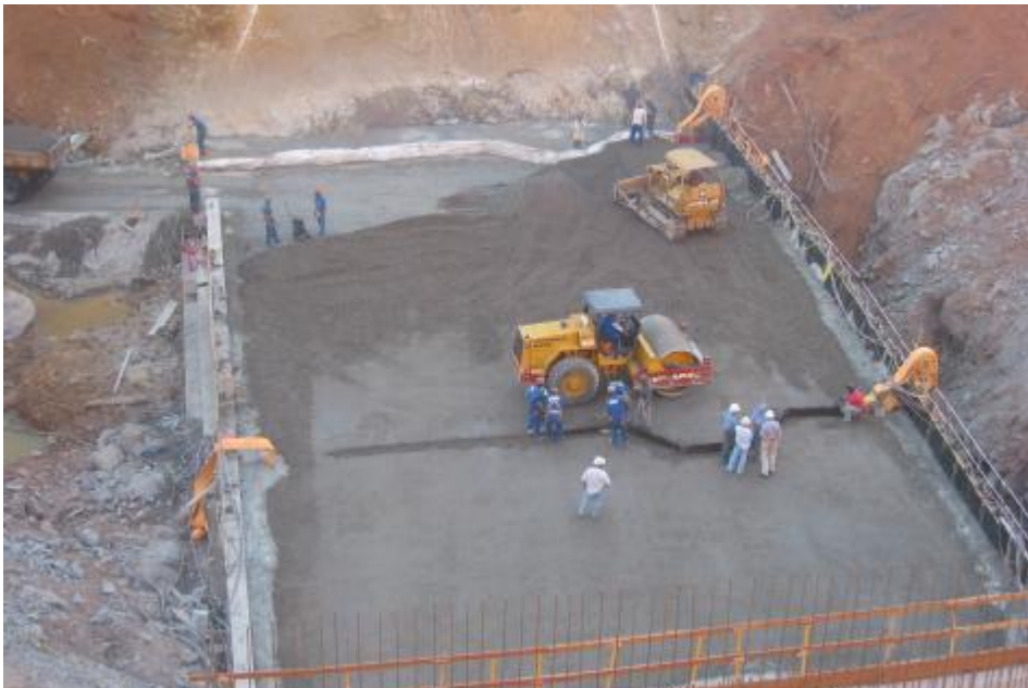
Fig. 8 Picada RCC dam, two upstream-downstream transversal joints Barrage BCR de Picada, deux joints transversaux amont-aval
