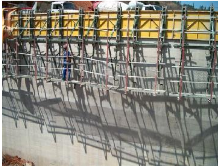
Fig. 5 Picada RCC dam, upstream view of the formwork panels and double curvature Barrage BCR de Picada, vue amont des coffrages et de la double courbure
