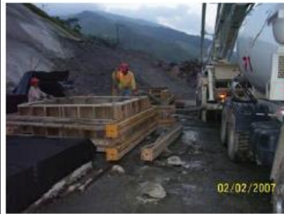
Figura 5-I-03- Posicionamento do caminhão betoneira para a descarga do concreto na bomba
