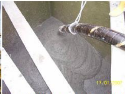
Figura 5-I-06- Lançamento no molde do Bloco de Medição de temperaturas
