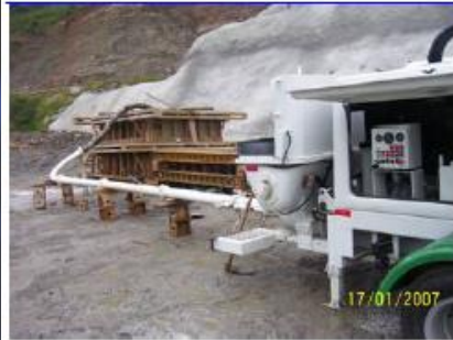
Figura 5-I-01- Preparativo para a concretagem de um dos Blocos, através do bombeamento
