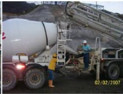
Figura 5-I-04- Descarga do concreto do caminhão na bomba
