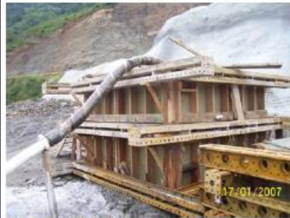
Figura 5-I-05- Bombeamento do concreto
