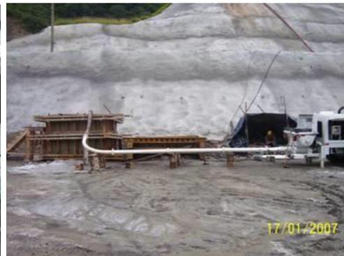
FIGURAS 7.1- Preparativos concretagem de um dos Blocos, através do uso de concreto bombeado
