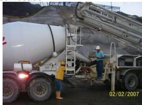
FIGURAS 7.2- Posicionamento do caminhão betoneira para a descarga do concreto na bomba
