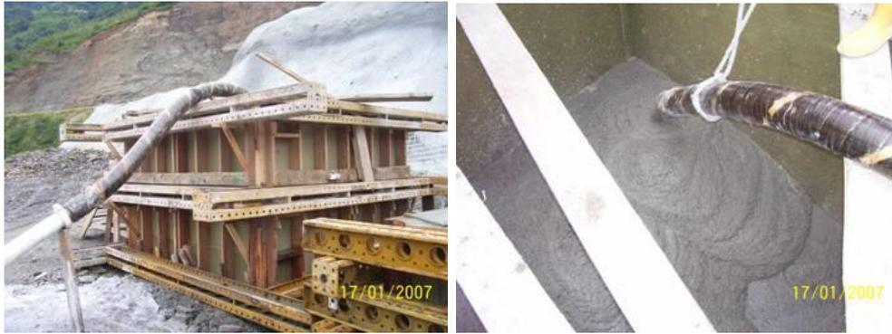
FIGURA 7.3- Lançamento do Concreto no Bloco para a medição das Temperaturas
