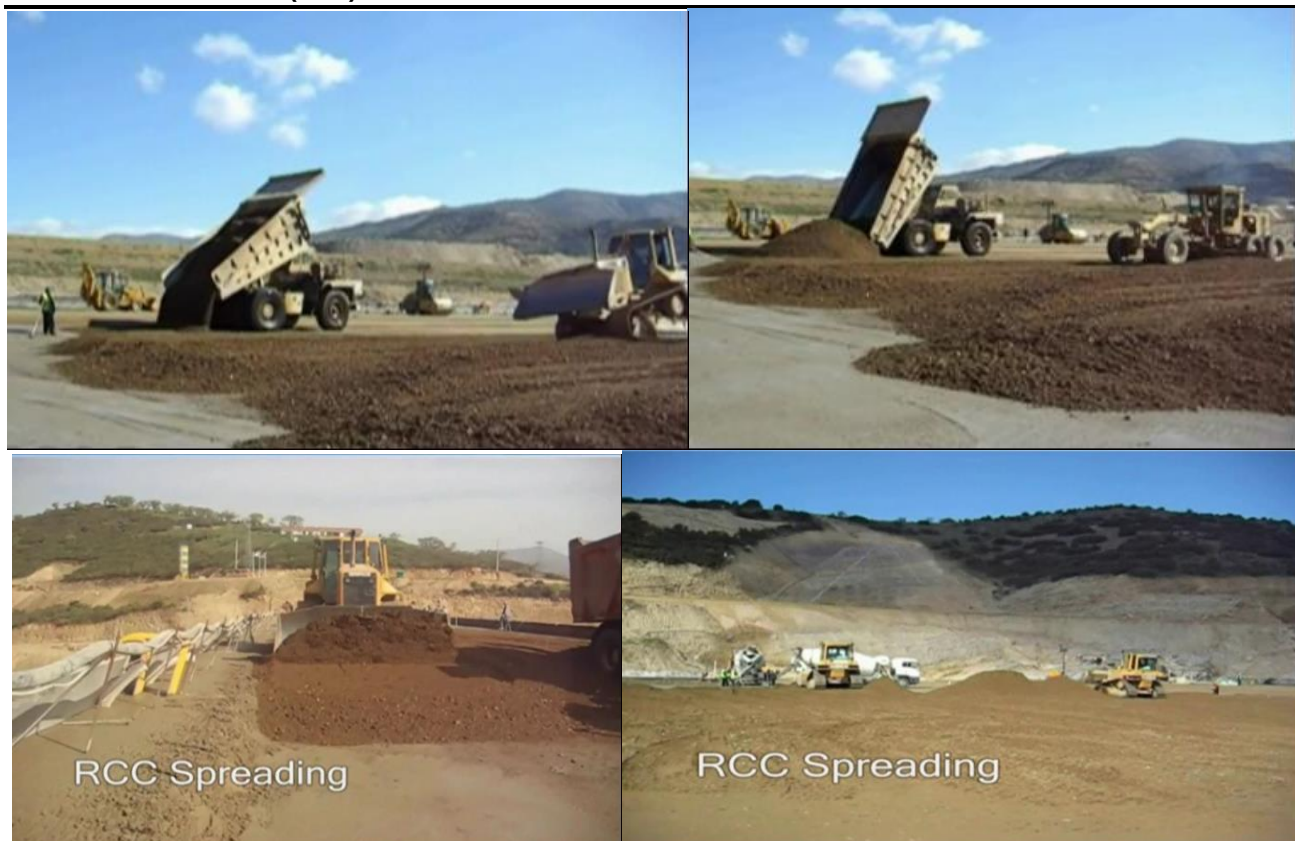
Figuras 10-11-Aspectos de espalhamento do CCR em camadas de altura 300, utilizando trator de lâmina frontal (“Bulldozer”) e Moto Niveladora (“Motor Grade”) na barragem de Beydag-Turquia- 2007
