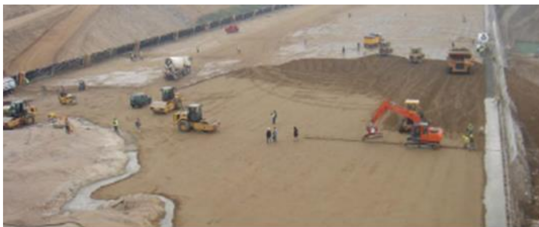
Figura 10-33- Vista geral das atividades de execução da concretagem na barragem de Beydag- Turquia- 2007
