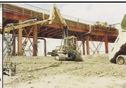
Figuras 10-15-Aplicação de concreto massa convencional em rampas, em Blocos do vertedouro de Tucuruí 1982
