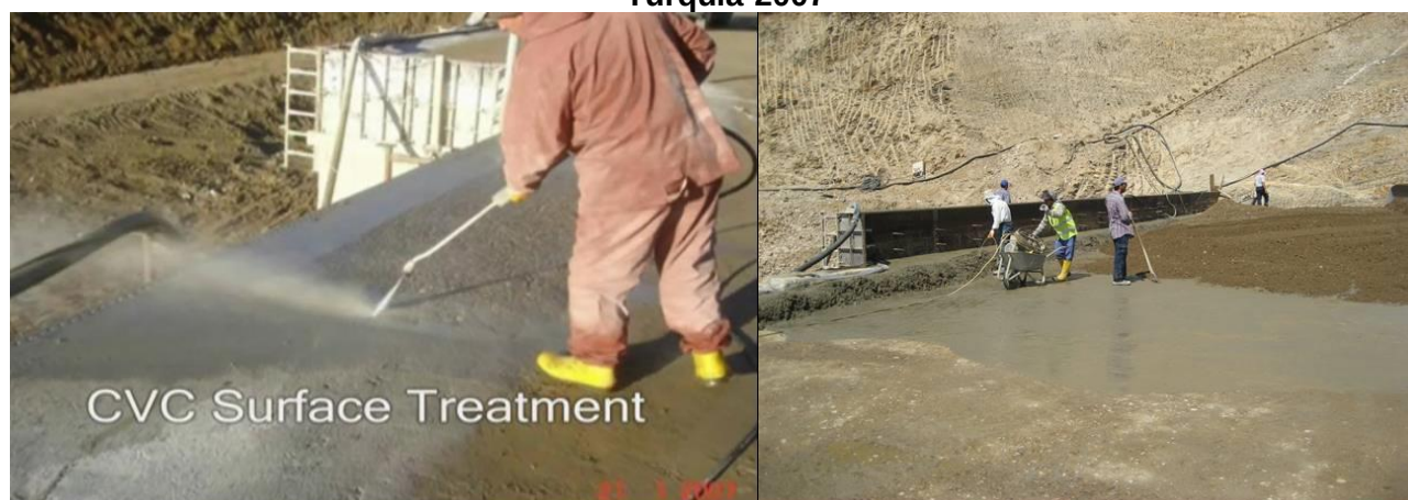
Figura 10-29- Tratamento do superfície da Junta de Construção do concreto de face, com “corte-verde”- Beydag- Turquia-2007
