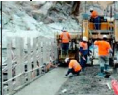
Figuras 10-19-Aplicação e Adensamento do Grout Enriched RCC (GE-RCC), por vibroacabadora [68]
