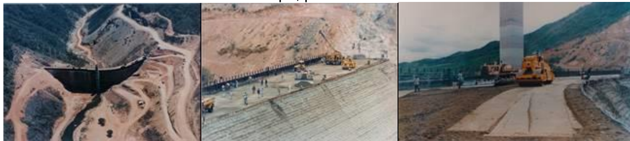
Figuras 04-03- Construção da Barragem de Saco de Nova Olinda em CCR no Brasil- 1986
