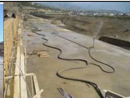
Figuras 10-25- Cura do CCR- com nebulizador manual e fixo em Beydag-Turquia-2007
