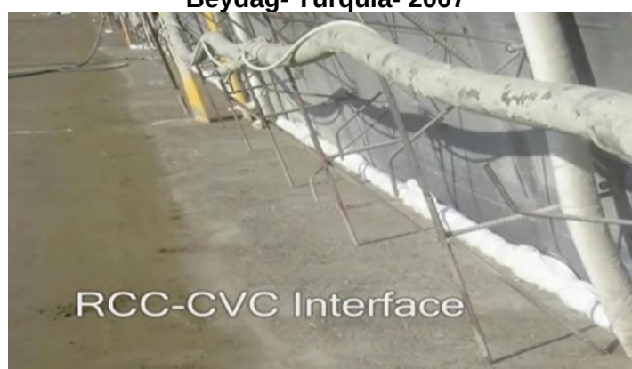
Figura 10-34- Vista em detalhe da interface do CVC e CCR, devidamente nivelados, adensados e acabados- as atividades de execução da concretagem na barragem de Beydag- Turquia- 2007
