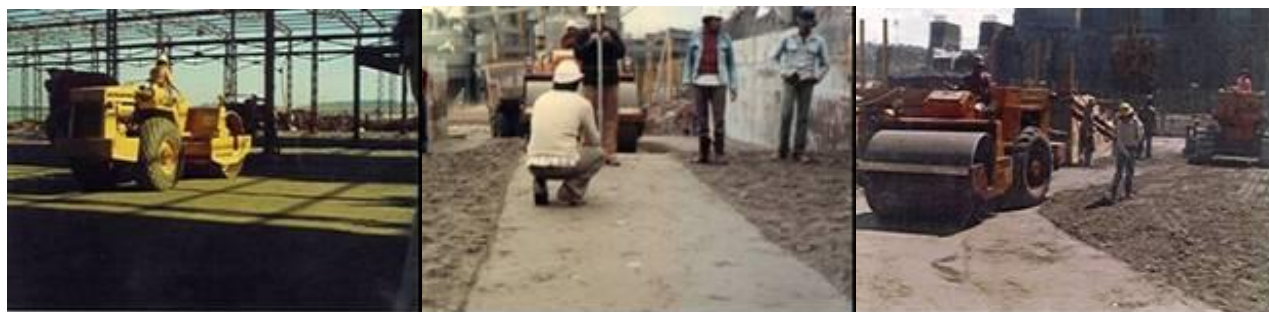
Piso do Almoxarifado do Construtor de Itaipu-1976
