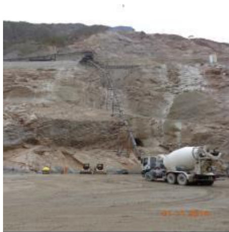
Figuras 10-07-Vistas do chute adotado para manuseio do CCR Cerro del Aguila-2014
