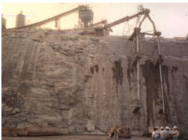
Figura 10-06-CCR manuseado por Correia-Chute-Caminhões Basculantes na praça da Barragem- Aplicação Inédita em Capanda –Angola- em 1990
