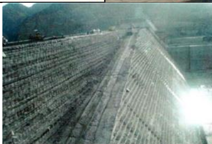
Figuras 10-16-Execução de barragem de CCR em rampa como usado nas barragens de “CFRD”.
