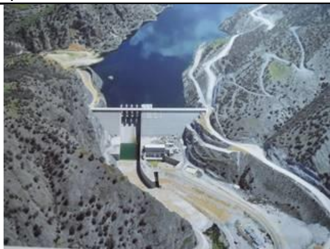
Figuras 06-11 Barragem de Cindere em CCR com face usando Pré-moldados com manta de PVC (interna), construída em 2004, na Turquia
