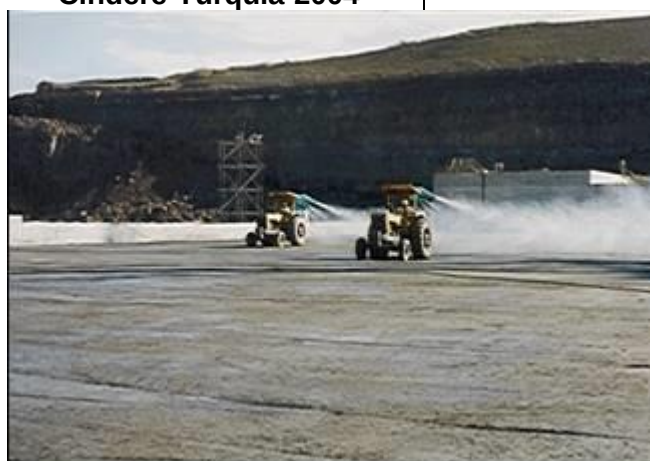
Figura 10-26- Cura com nebulizadores agrícola tipo trator fumigador- Salto Caxias- Brasil- 1998
