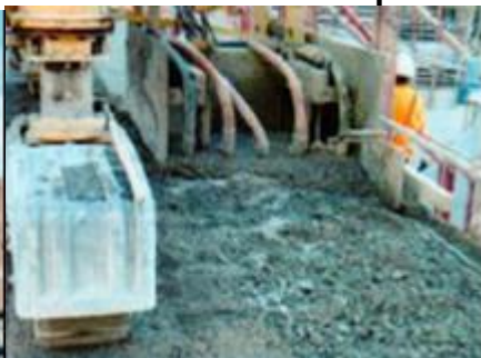
Figuras 10-19-Aplicação e Adensamento do Grout Enriched RCC (GE-RCC), por vibroacabadora [68]
