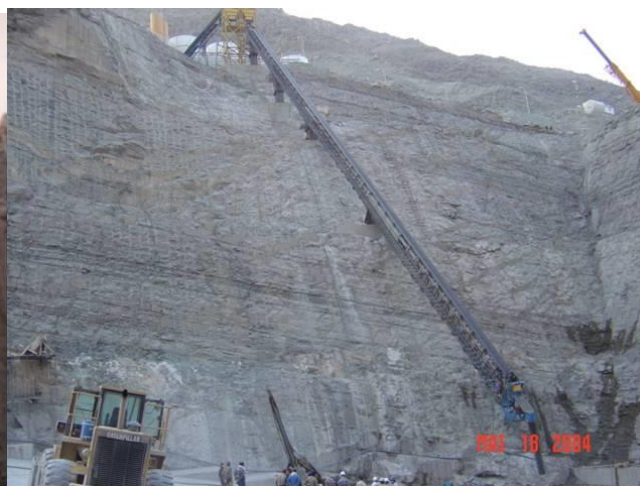
Figura 10-07-Vista do chute adotado para manuseio do CCR em Jeghin-Iran-2004
