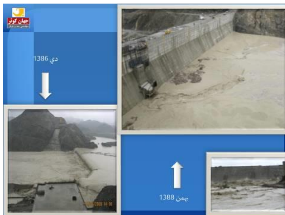
Figuras 09-02-Vistas durante a construção da Barragem de Zirdan-Iran -2005, preparada para as enchentes decorrente das Monções.
