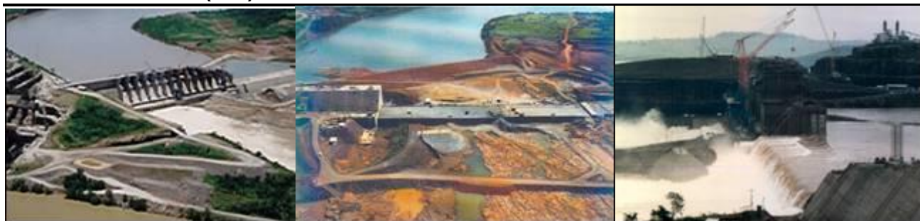
Figuras 09-01-Vistas durante a construção de Salto Caxias, no Brasil em -1997, preparada para permitir o galgamento.
