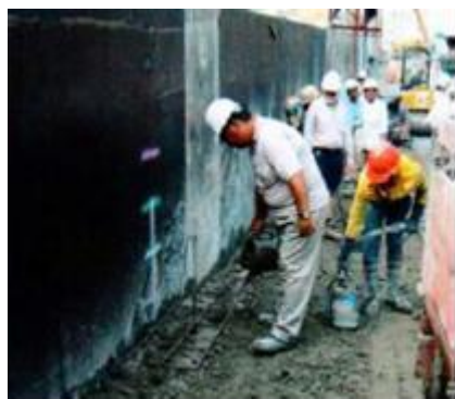
Figuras 10-18-Adensamento do Grout Enriched RCC (GE-RCC), com vibradores de imersão operados manualmente ou acoplados a máquinas [68]
