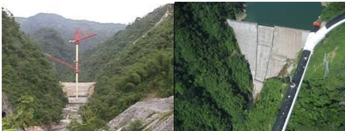
Figura 04-07- Barragem de Miel I – Colômbia
