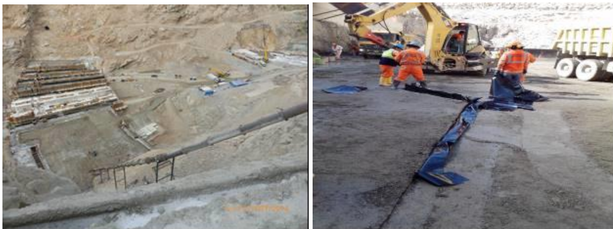
Figuras 07-06-Vistas da Barragem e da conformação da Junta de Contração Chavetada, na Barragem da UHE Cerro del Águila- Peru-2014-2015
