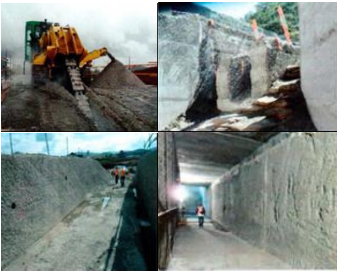
Figuras 10-37- Conformação de galerias pelo uso de máquina “valetadeira” [68]
