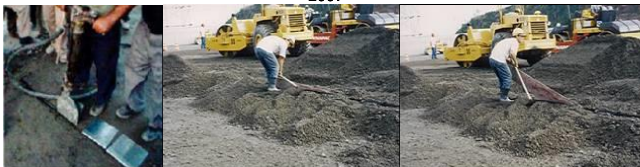
Figuras 10-21- Moldagem da Junta de Contração, através da inserção de lâmina metálica com auxílio de ferramenta Manual (rompedor vibratório)- Zirdan-Iran- 2007
