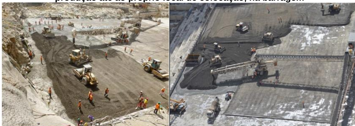
Figuras 10-034-Vistas do sistema de manuseio o CCR na Gibe III (Cortesia do Eng. Kootaro Sawada), utilizando “all conveyor” com final distribuição pelo “Crawler Placer”)
