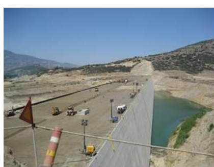
Figuras 06-10 Barragem de Beydag e CCR com face usando Pré-moldados com manta de PVC (interna), construída em 2007, na Turquia
