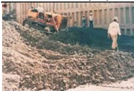
Figura 10-14-Aplicação inicial de concreto massa convencional em rampas, no Bloco H-12/13-C- em Itaipu- 1977/1978
