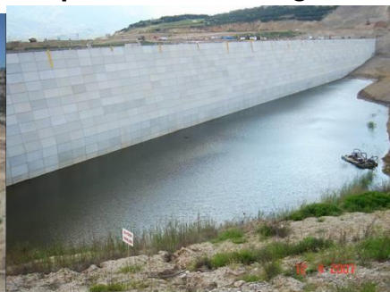
Figuras 06-10 Barragem de Beydag e CCR com face usando Pré-moldados com manta de PVC (interna), construída em 2007, na Turquia
