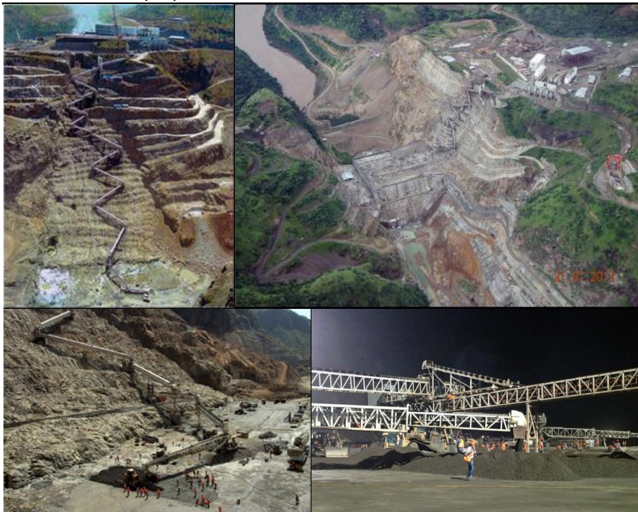
Figuras 10-03-Vistas do sistema de manuseio o CCR na Gibe III na Etiópia em 2014 (Cortesia do Eng. Kootaro Sawada), utilizando “all conveyor” desde as centrais de produção até ao próprio local de colocação, na barragem
