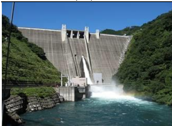
Figura 06-07-Barragem de Miyagase (Japão) terminada em 2001. Tem 155m de altura, 400m de crista e 1.600.000 m 3 de CCR, com face em CVC, evidenciando ausência de infiltrações
