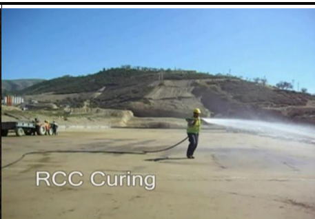
Figuras 10-25- Cura do CCR- com nebulizador manual e fixo em Beydag-Turquia-2007
