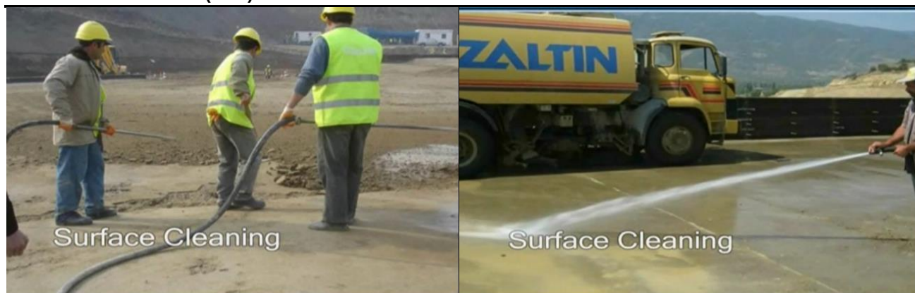
Figuras 10-28- Preparo da superfície da Junta de Construção do CCR, com a retirada de material solto por jato de ar úmido a baixa pressão e lavagem da superfície- Beydag-Turquia-2007
