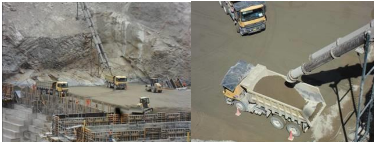
Figuras 10-08-Vistas adicionais do Chute adotado na Barragem de CCR do Projeto Hidrelétrico de Cerro del Águila-Peru-2014
