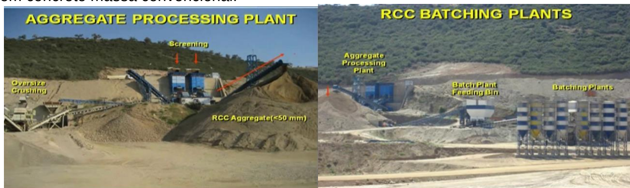
Figuras 10-01-Vistas do sistema de beneficiamento de agregados e de produção do CCR em Beydag-Turquia, utilizando uma única faixa granulométrica (já mencionado anteriormente)- 2007.
