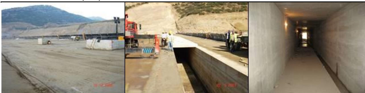
Figuras 10-36- Poços e galerias moldadas sendo cobertas com pre-moldados, bem como o aspecto interno após completada, na barragem de Beydag- Turquia- 2007
