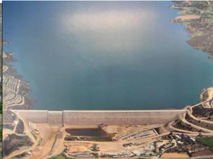
Figuras 06-10 Barragem de Beydag e CCR com face usando Pré-moldados com manta de PVC (interna), construída em 2007, na Turquia
