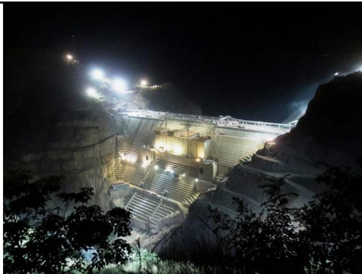
Figura 10-05-Vista próxima ao término da construção de Gibe III- em dezembro 2014
