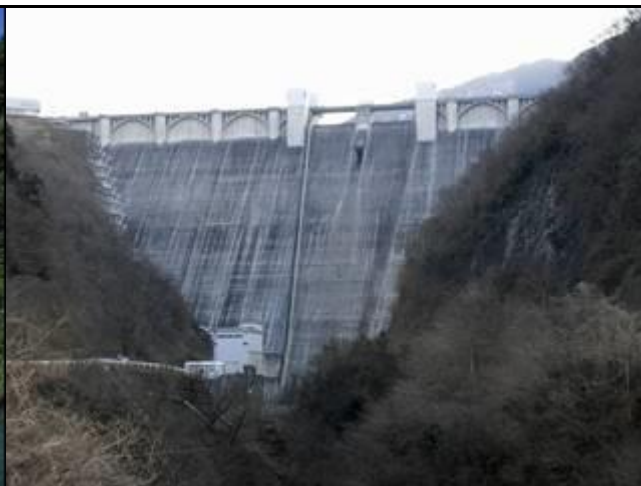
Figura 06-08-Barragem de Urayama (Japão) terminada em 1999. Tem 156m de altura, 372m de crista 1.600.000 m 3 de CCR, com face em CVC, evidenciando ausência de infiltrações
