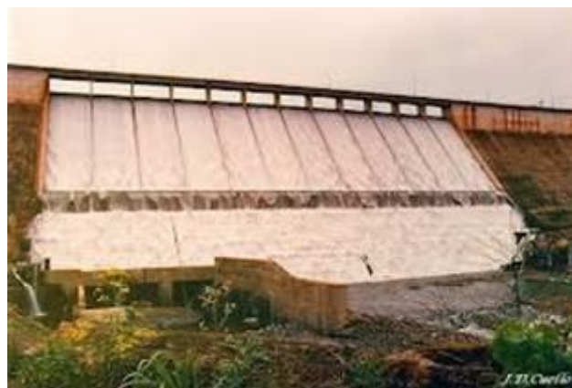
Figura 04-09- Barragem da Hidrelétrica de Urugau-i- Argentina, com 77m de Altura; 680m de Crista e Volume de CCR de 600.000m 3 - 1988
