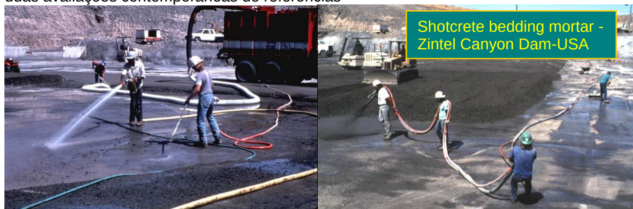
Figura 10-31- Preparo do superfície da Junta de Construção do concreto de face, com “corte-verde”- Estudo do Corps of Engineers- USA Army- 2002 [69]
