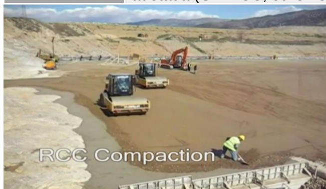
Figuras 10-17-Compactação do CCR e adensamento do CVC de Face com vibrador de imersão
