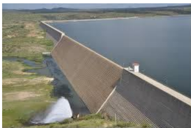
Figura 04-08- Barragem de Santa Cruz do Apodi, com 58m de Altura; 1660m de Crista e Volume de CCR de 1.023.000m 3 - 2000
