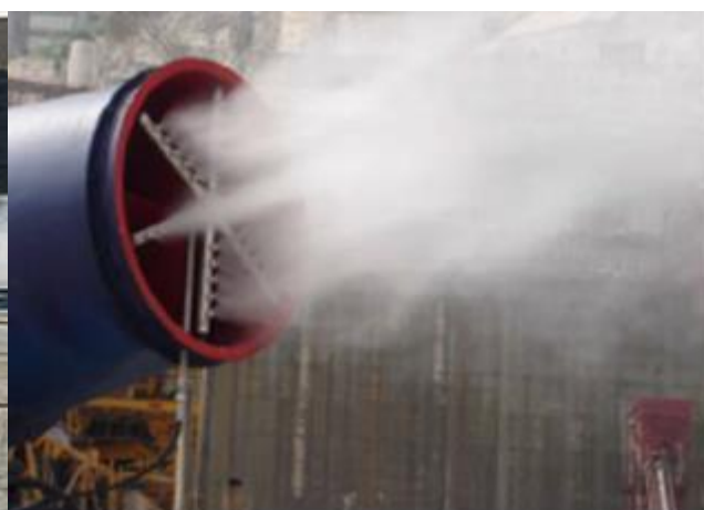
Figura 10-27- Cura com nebulizador Longtan- China-2007
