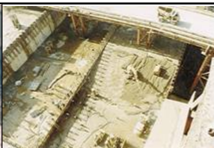
Figuras 10-15-Aplicação de concreto massa convencional em rampas, em Blocos do vertedouro de Tucuruí 1982
