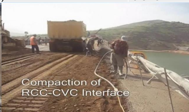
Figuras 10-17-Compactação do CCR e adensamento do CVC de Face com vibrador de imersão
