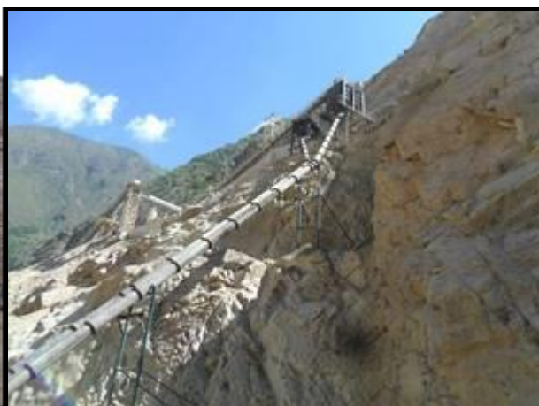
Figuras 10-07-Vistas do chute adotado para manuseio do CCR Cerro del Aguila-2014
