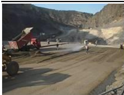
Figura 10-24- Nebulização durante as atividades de lançamento, espalhamento e compactação do CCR- Cindere-Turquia-2004
