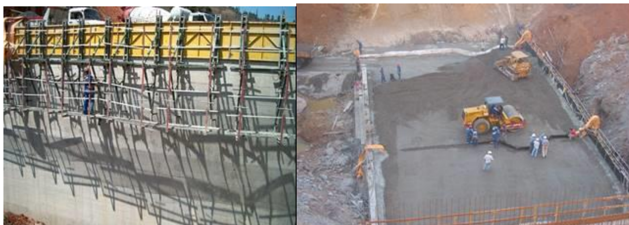
Figuras 07-05-Vistas do sistema de formas e da conformação da Junta de Contração Chavetada, na Barragem da UHE Picada-2002/2003
