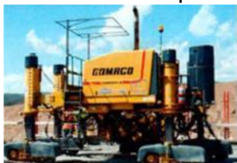
Figuras 10-19-Aplicação e Adensamento do Grout Enriched RCC (GE-RCC), por vibroacabadora [68]
