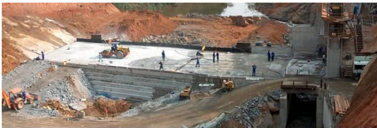
Figura 07-03-Vista geral da barragem da UHE Picada durante a construção
