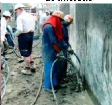
Figuras 10-18-Adensamento do Grout Enriched RCC (GE-RCC), com vibradores de imersão operados manualmente ou acoplados a máquinas [68]
