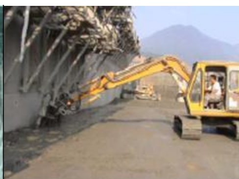
Figuras 10-18-Adensamento do Grout Enriched RCC (GE-RCC), com vibradores de imersão operados manualmente ou acoplados a máquinas [68]
