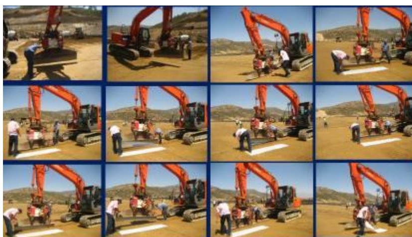
Figuras 10-20- Sequência de moldagem da Junta de Contração, através da inserção de lâmina vibratória, e posterior de filme plástico, na Barragem de Beydag- Turquia- 2007
