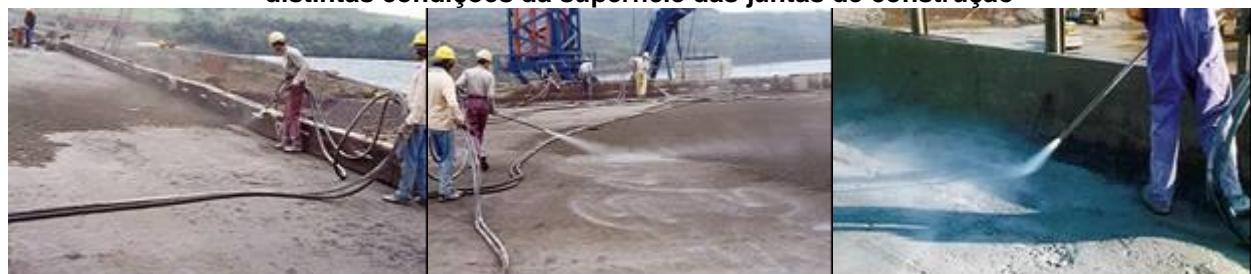
Limpeza da superfície da junta de construção para a subsequente colocação do CCR, usando jatos de ar úmido
