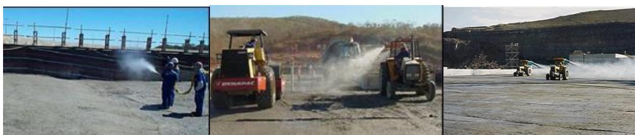
Proteção do CCR durante o lançamento e cura, com distintos equipamentos, ferramentas e maneiras durante a construção das barragens Brasileiras de CCR
