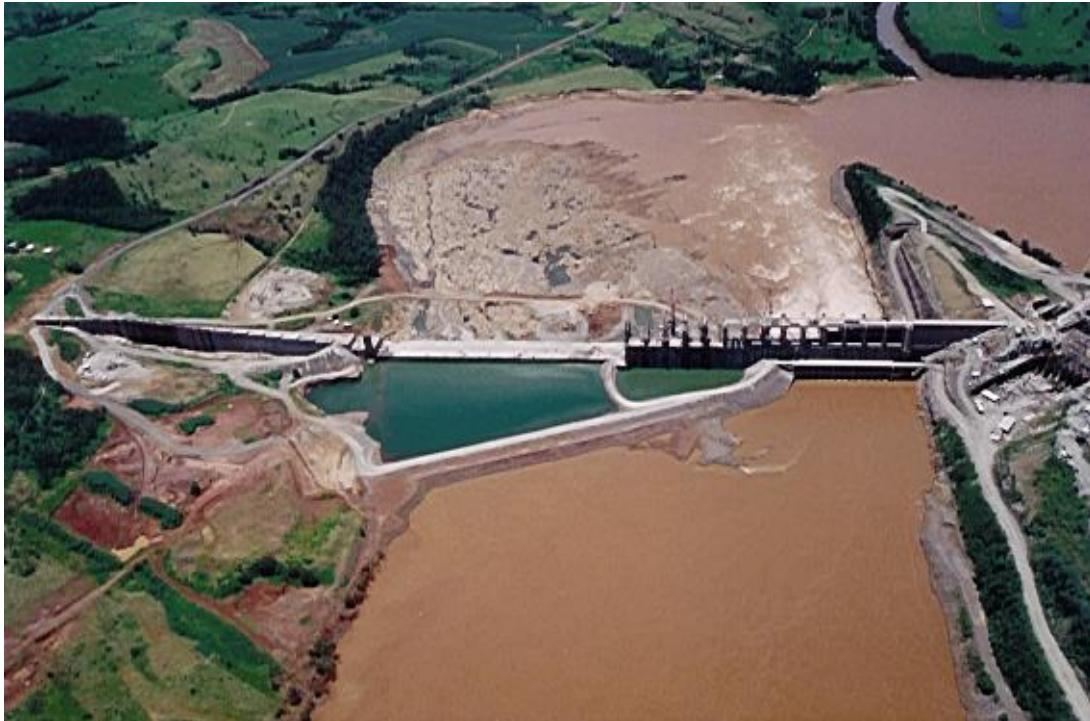
Salto Caxias durante a construção- época da preparação para grandes vazões – ao redor de 15.000m<sup>3</sup>/s- (7.500m<sup>3</sup>/s pelas adufas e 7.500m<sup>3</sup>/s sobre passando a barragem durante a construção)
