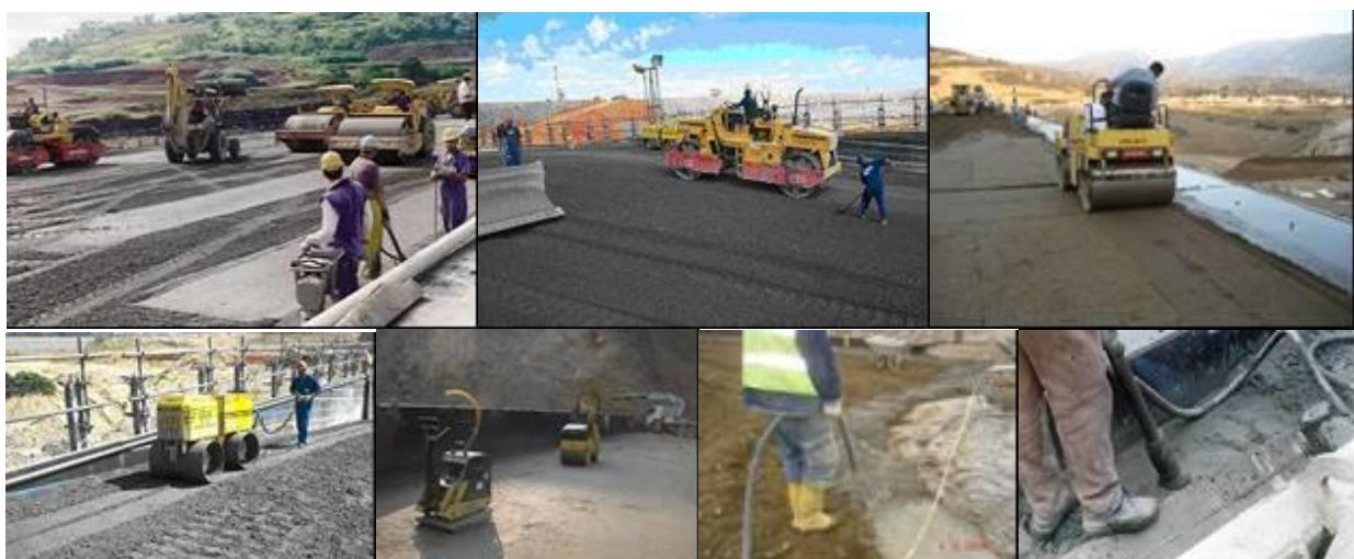
Rolos compactadores de diferentes tipos, modelos e dimensões, placas vibratórias para o CCR e vibradores de imersão para o CVC e/ou CCR enriquecido de uso comum no Brasil
