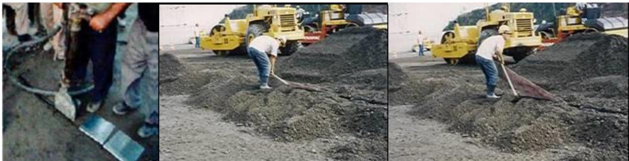
Moldagem da Junta de Contração, pela inserção de lâmina metálica com auxílio de um rompedor manual
