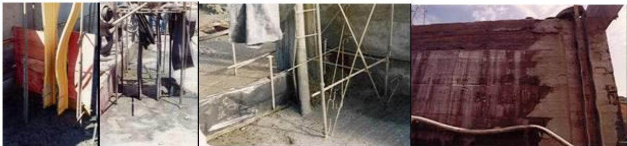
Dupla linha de veda-juntas de PVC, dreno e o aspecto da face com a junta de contração e o sistema de veda-juntas
