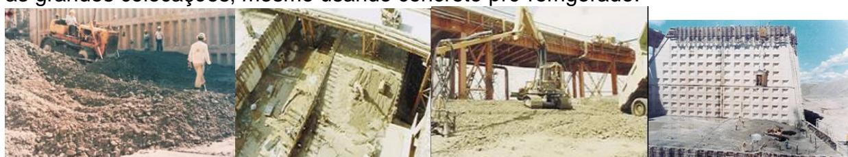
**Método de camada em rampa na colocação de CVC Massa durante a construção em Itaipu-1977**
