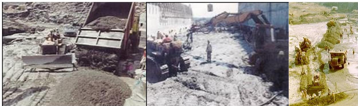
**Concreto Massa Convencional Vibrado (CVC Massa)** lançado diretamente por caminhão basculante fora de estrada, espalhado por “bulldozer” e vibrado com vibradores de imersão em 1977-Itaipu
