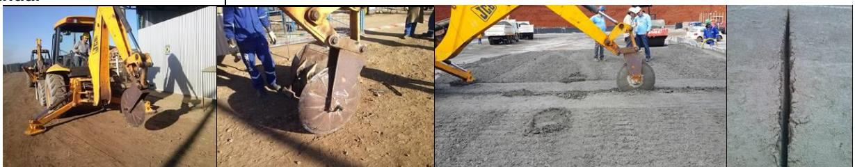
Uma nova e simples alternativa para a moldagem da Junta de Contração recentemente adotada em barragem Brasileira de CCR.
