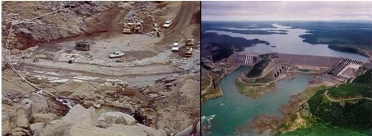
**CHESF- Proteção do Enrocamento, com CCR, para sobre passagem na barragem de Xingó (tipo CFRD)**
