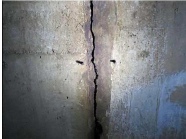
Aspecto da abertura de uma Junta de Contração no interior da barragem. A Junta de Contração fora posicionada sobre a inflexão da fundação rochosa de elevado Módulo de Elasticidade
