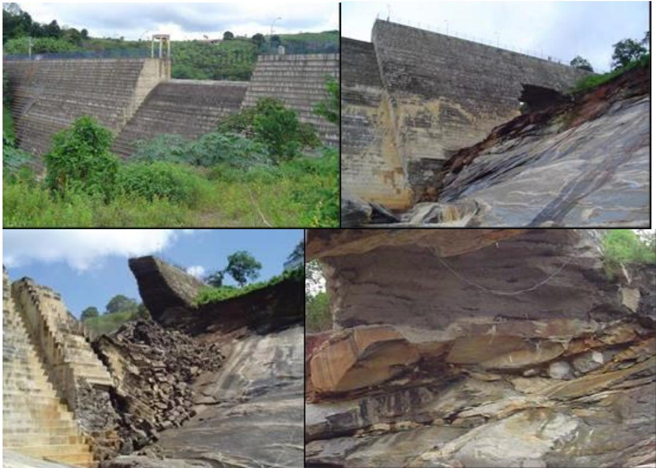
**Sequência da ruptura, e a rocha alterada e o bloco sob a região do contato da barragem com a fundação.**
