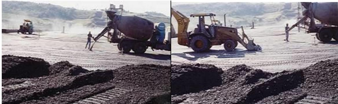
Aplicação da argamassa de berço sobre a superfície da junta de construção do CCR
