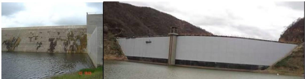
Infiltrações devidas a falhas na face de montante
