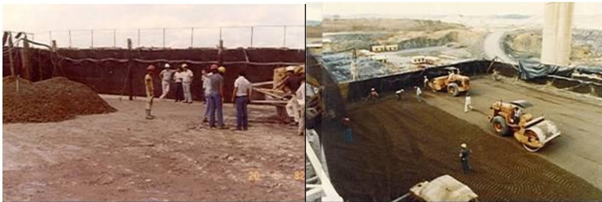
Colocação do CCR em um bloco da Eclusa de Navegação da Barragem de Tucuruí- 1982
