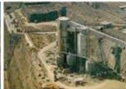
Três instalações verticais de produção de concreto (cada uma produzindo 200m<sup>3</sup>/hora) com uma betoneira central basculante que foram usadas por mais de 40.000 horas para produzir mais de 8.000.000 m<sup>3</sup> de concreto massa em Itaipu (margem esquerda) - Brasil - 1977 até 1983 (Barragem Itaipu - foto por Andriolo)
