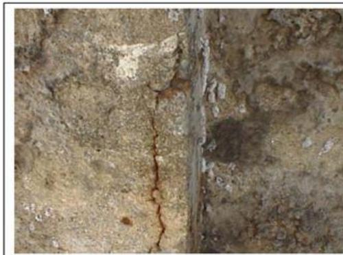
Figura PoçoBranco- 15- Detalhe da superfície do concreto do Pilar da Passarela evidenciando a fissuração devido à corrosão da armadura..
