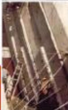
Juntas de contração em barragens e veda-juntas iniciando na fundação (Al Wehdah - Jordânia - 2006) e 3 linhas na barragem de gravidade ativiada de Itaipu (1980) (por Andriolo)
