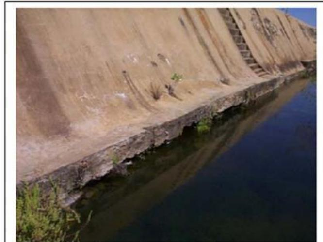
Figura Araras - 13- Detalhes observados na soleira do vertedouro, evidenciando zonas erodidas com ruptura da argamassa de revestimento e do concreto ciclópico, inclusive dando espaço ao crescimento de vegetação.
