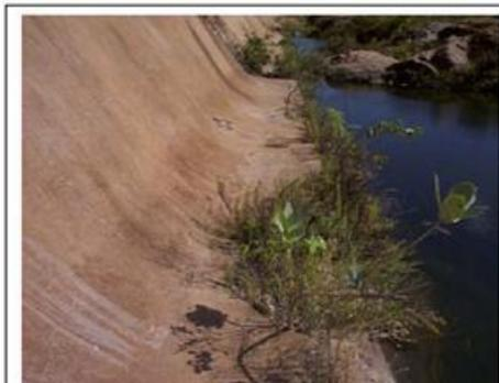
Figura Araras - 12- Aspectos gerais e detalhes observados na soleira do vertedouro, evidenciando zonas erodidas com ruptura da argamassa de revestimento e do concreto ciclópico, inclusive dando espaço ao crescimento de vegetação.
