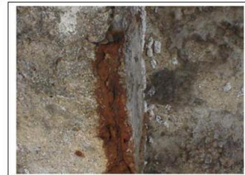
Figura PoçoBranco- 16- Detalhe na superfície do concreto do Pilar da Passarela evidenciando a expansão devido à corrosão. O fragmento mostrado na foto 15 foi retirado com a mão.
