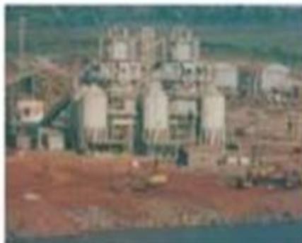
Dois instalações verticais de produção de concreto (cada uma produzindo 200m<sup>3</sup>/hora) com uma betoneira central basculante que foram usadas por mais de 40.000 horas para produzir mais de 8.000.000 m<sup>3</sup> de concreto massa em 4 grandes barragens no Brasil - 1966 até 1983 (Barragem de Ilha Solteira - foto por Andriolo)
