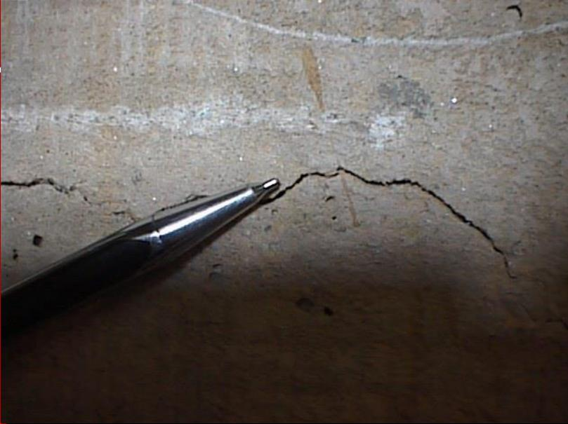
Processo que leva à fissuração decorrente da reação de  $\text{CaO}$  do cimento e determinados agregados contendo sulfetos.
