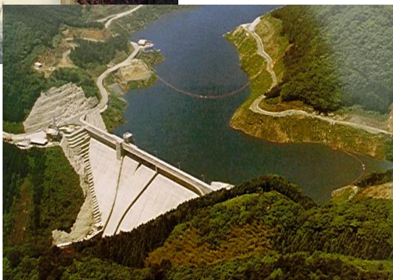
Shimajigawa [04] Barragem de CCR no Japão- 1980
